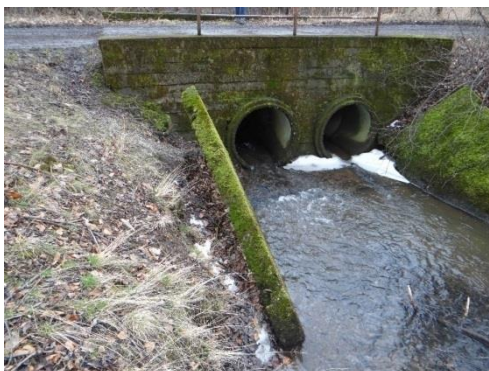
FOT.2 WIDOK NA ISTNIEJĄCY PRZEPUST
