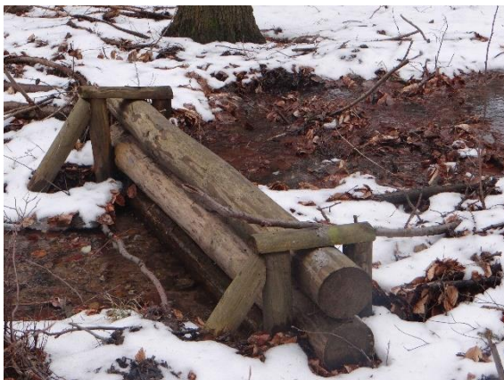
Przykładowy deflektor spowalniający odpływ
