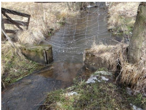
FOT.3 WIDOK NA CZĘŚĆ POTOKU WRAZ Z ISTNIEJĄCĄ ZASTAWKĄ
