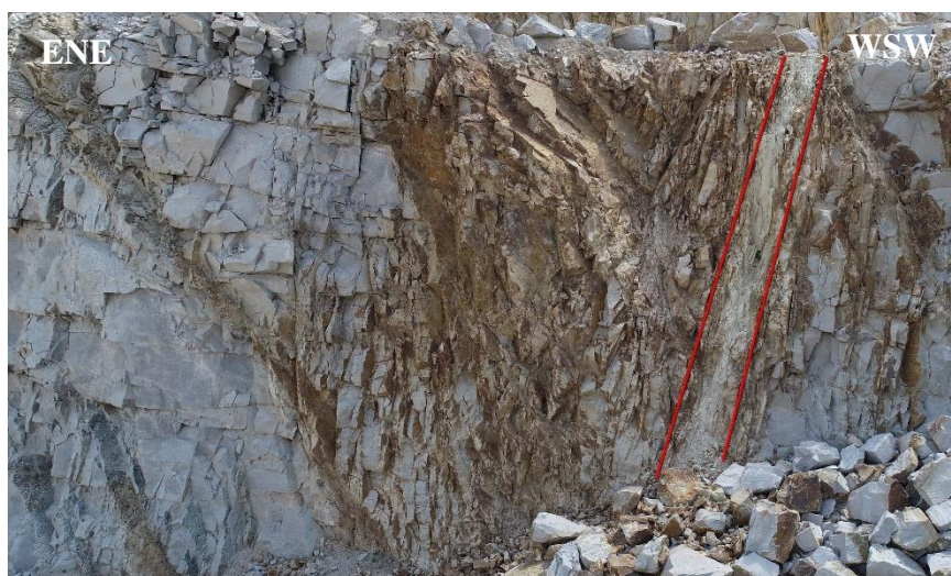
Figura 5.53. Kłm w Górze Sobockiej, zdjęcie strefy Sa1. Prawdopodobna strefa głównego przemieszczenia uskoku, zaznaczona na czerwono
