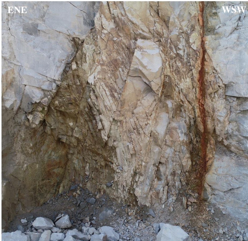
Figura 5.54. Kłm w Górcie Sobockiej, strefa Sa2 w profilu GSp1. Z prawej strony strefa silnego zniszczenia (prawdopodobnie strefa głównego ślizgu) o czerwonym zabarwieniu. Ciemny obszar po prawej stronie związany jest z wypływem wód.
