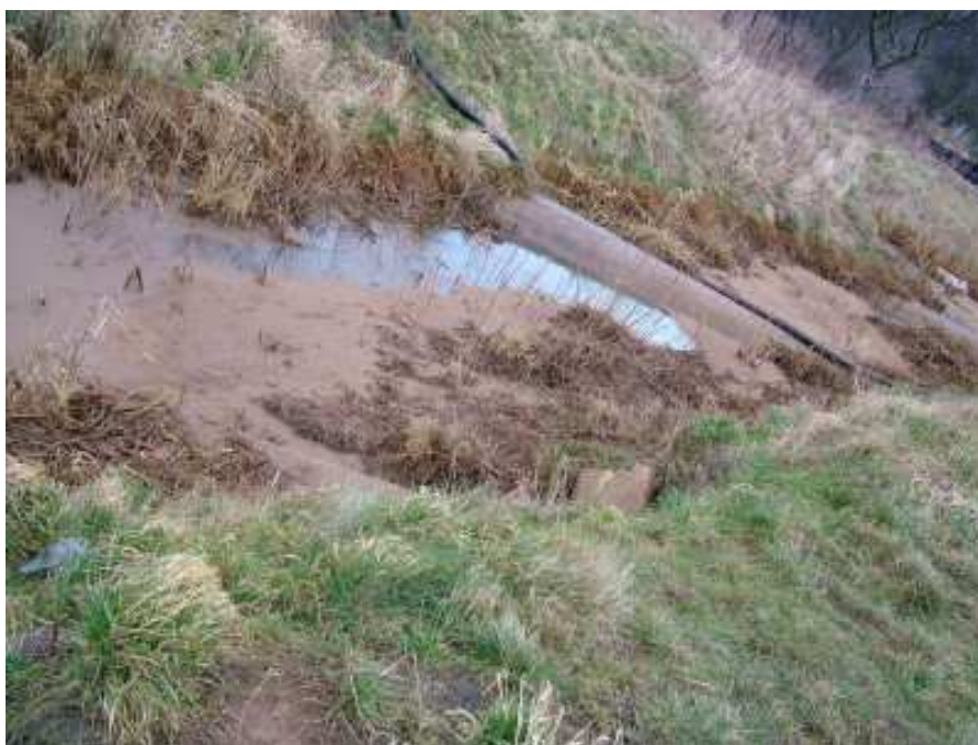
Fot. 3. Rów melioracyjny pokryty sorbentem
