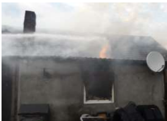
Fot. 22. Pożar budynku jednorodzinnego
