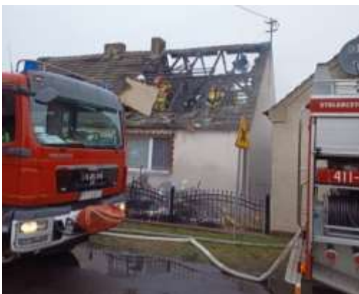
Fot. 32. Pożar budynku jednorodzinnego
