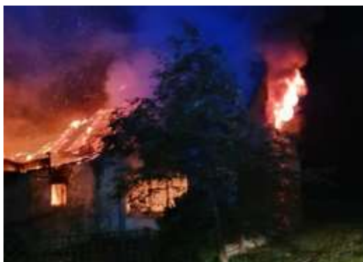
Fot. 26. Pożar budynku mieszkalnego
