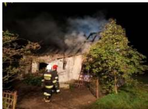
Fot. 27. Pożar budynku mieszkalnego
