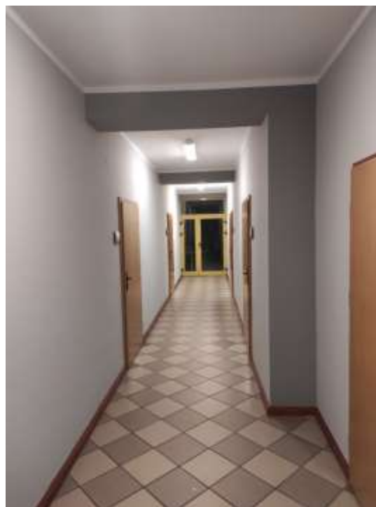
Fot. 69. Pomieszczenia komendy po malowaniu
