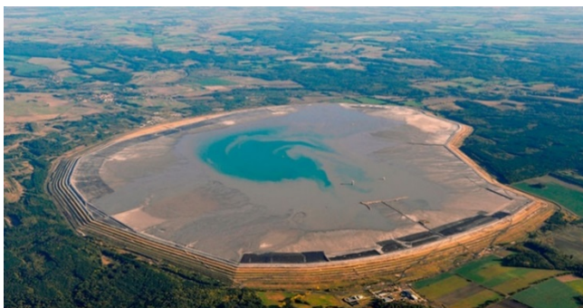
Rys. 4.4. Widok na składowisko odpadów poflotacyjnych Żelazny Most
