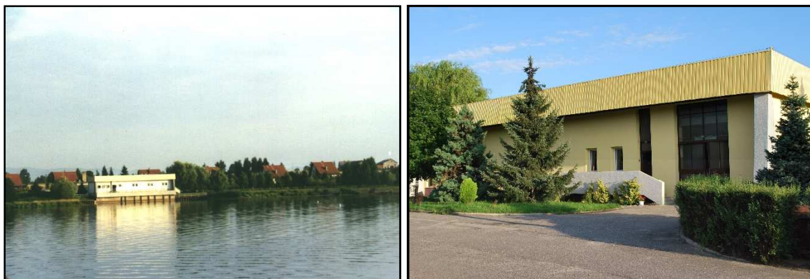
Ujęcie wody przemysłowej w Łące.
