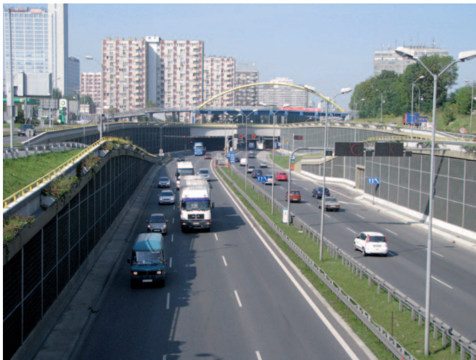
Fot. 10. Ekrany akustyczne wzdłuż Drogowej Trasy Średnicowej, Katowice (źródło: WIOŚ)
