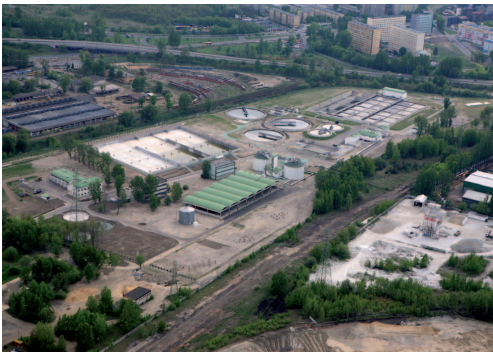
Fot. 9. Oczyszczalnia ścieków „Centrum-Gigablok” (źródło: RPWiK SA w Katowicach)
