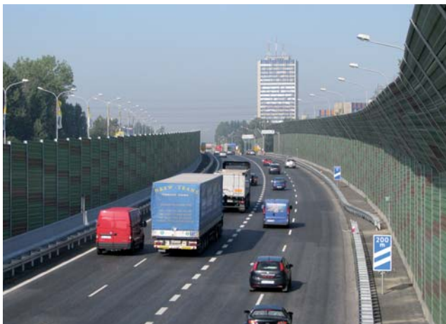
Fot. 2. Ekran akustyczny wzdłuż al. Górnośląskiej (autostrada A4), Katowice
