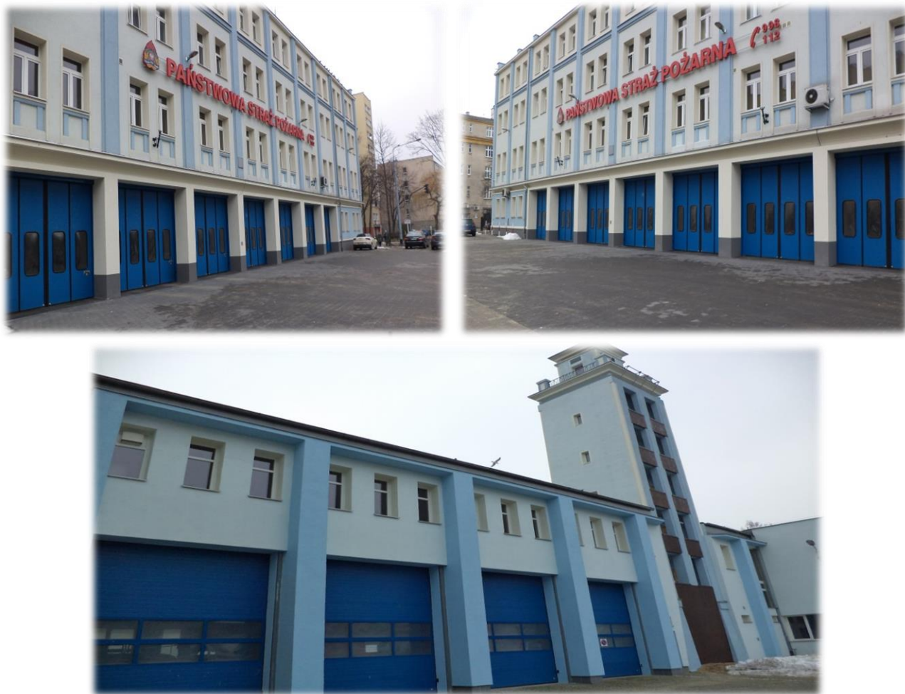
Fot. 43 Remont nawierzchni placów, chodników i dróg wraz z zagospodarowaniem terenu na odcinku od ul. Starowiejskiej do ul. Wójta Radtkego wraz z terenem wewnętrznym należącym do KM PSP w Gdyni.
