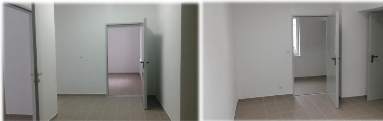
Fot. 42 Remont pomieszczeń magazynowych z adaptacją na archiwum zakładowego w Komendzie Powiatowej PSP w Człuchowie.
