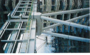
5 Most Skybridge w Petronas Towers: (a) widok wież pokazujący most łączący 41. i 42. piętro, (b) schemat zagospodarowania przestrzennego wind, pokazujący przełączenie windy w skylobby na 41. i 42. kondygnacji, (c) dwupoziomowa konstrukcja skybridge
