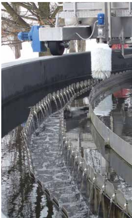
Współfinansowana przez UE modernizacja oczyszczalni ścieków w Grodzisku Mazowieckim.
