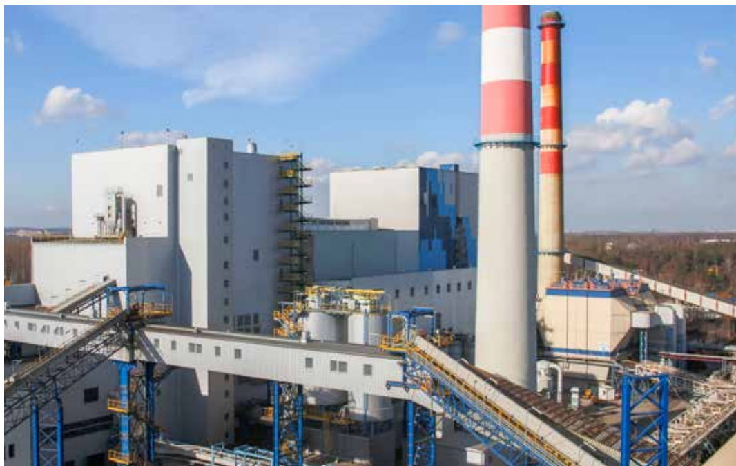
Kocioł na biomasę w elektrowni Jaworzno III. Fot. Wojciech Piechocki
