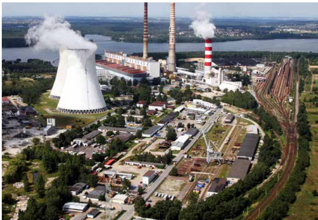
Dzięki środkom NFOŚiGW w okresie 25 lat zmodernizowano największe polskie elektrownie. Fot. Archiwum/NFOŚiGW
