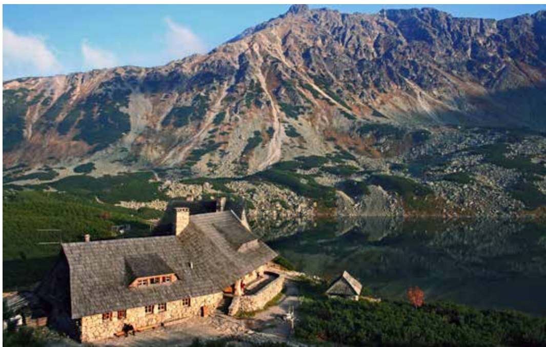
Zmodernizowane z finansowym udziałem NFOŚiGW schronisko w Dolinie 5 Stawów Polskich w Tatrach. Fot. Schronisko 5 Stawów
