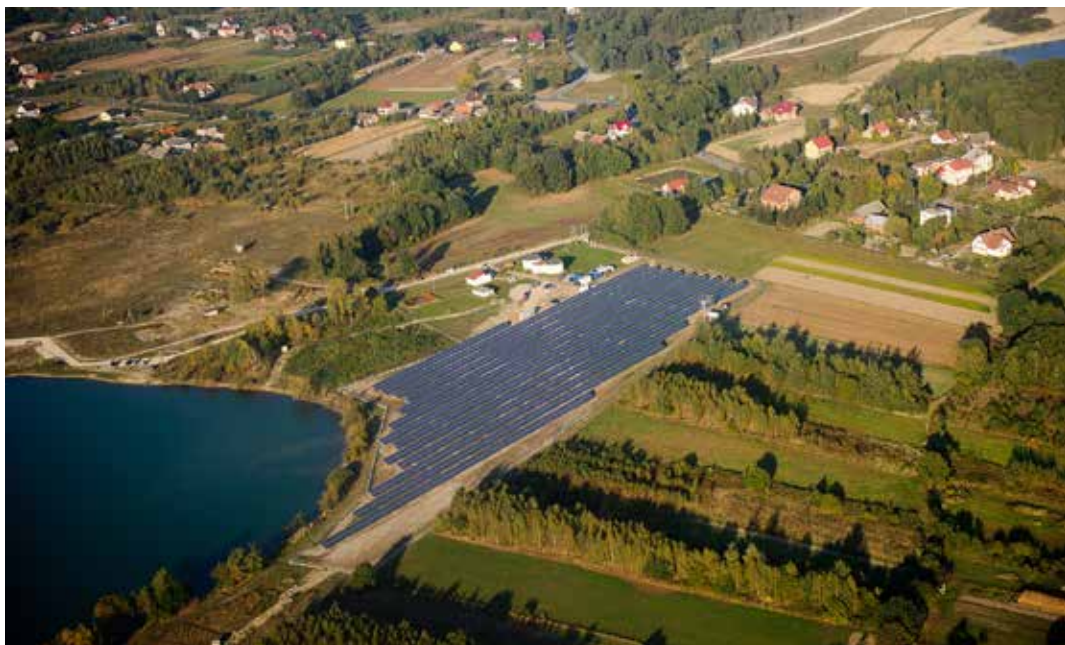
Pierwsza w Polsce przemysłowa farma fotowoltaiczna dofinansowana m.in. przez WFOŚiGW w Krakowie.
