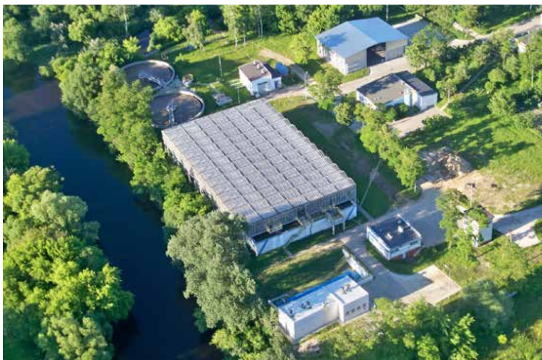
Oczyszczalnia ścieków w Sochaczewie. Fot. ZWIK Sochaczew Sp. z o.o.
