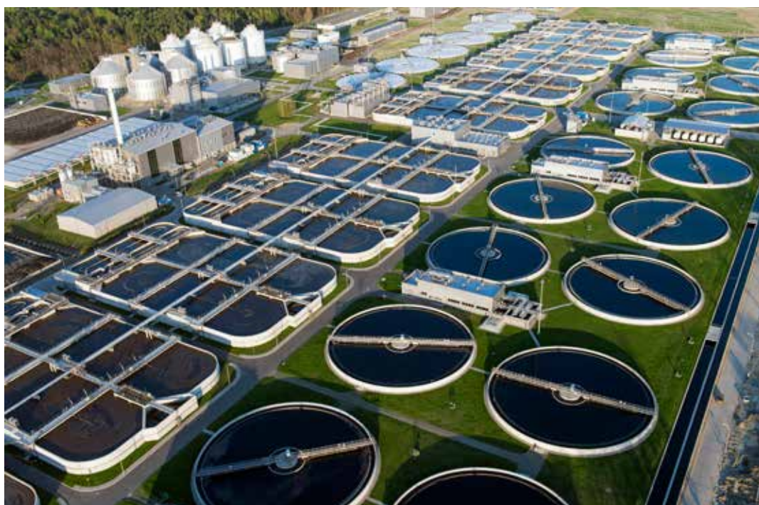
Oczyszczalnia ścieków „Czajka” w Warszawie. Fot. Kacper Kowalski dla MPWiK
