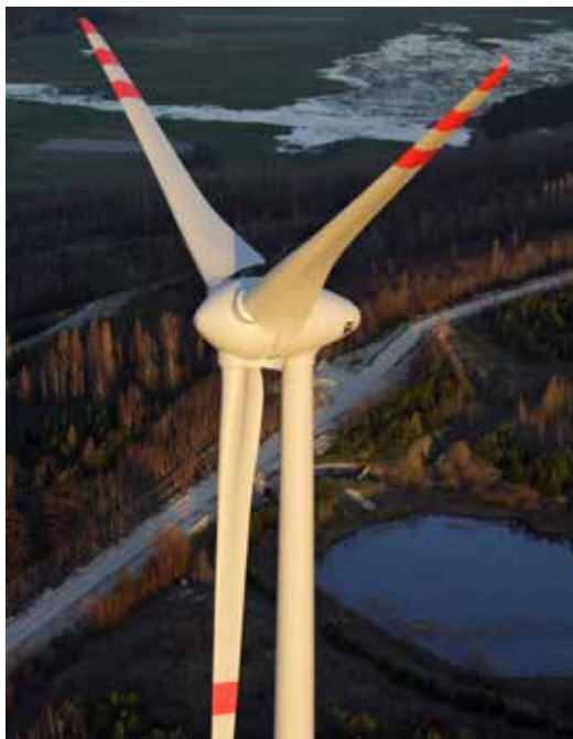
Turbina wiatrowa w elektrowni Kamieńsk.
