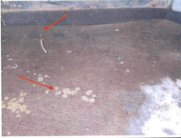
Fot. 9. Widoczne zawilgocenia wykładziny i elementów wyposażenia w pomieszczeniach piwnic o przeznaczeniu na bibliotekę.
