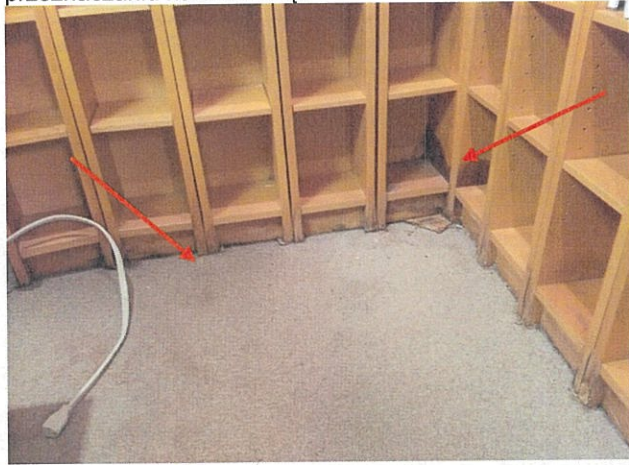
Fot. 9. Widoczne zawilgocenia wykładziny i elementów wyposażenia w pomieszczeniach piwnic o przeznaczeniu na bibliotekę.
