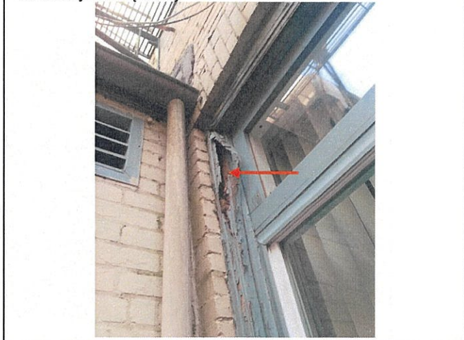
Fot. 64. Widok na zniszczenia stolarki okiennej - widoczne od strony zewnętrznej.
