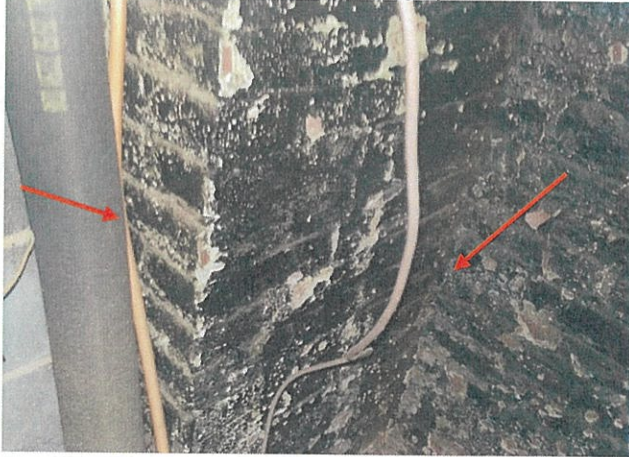
Fot. 5. Widok na zawilgocenia w pom. piwnicznym przy schodach zewnętrznych i znaczne zagrzybenie.
