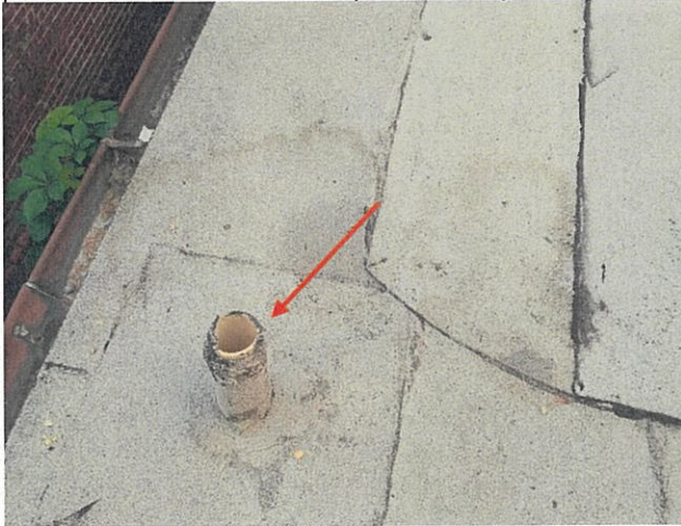
Fot. 81. Widok na brak przekrycia wywietrznika dachu pomieszczenia dobudówki na parterze budynku.
