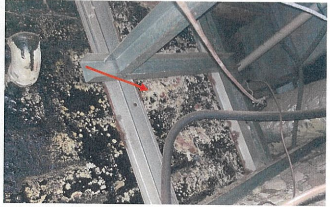
Fot. 6. Widok na zawilgocenia w pom. piwnicznym przy schodach zewnętrznych i znaczne zagrzybenie.
