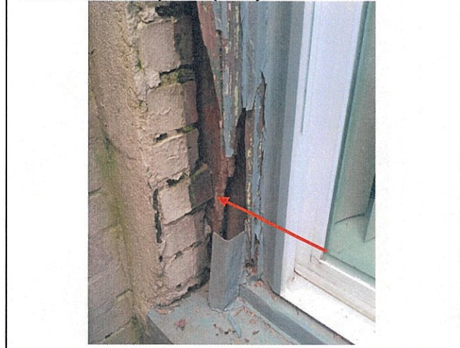
Fot. 63. Widok na zniszczenia stolarki okiennej - widoczne od strony zewnętrznej.
