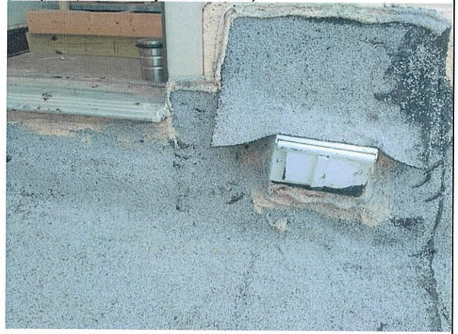
Fot. 90. Widok na gniazda elektryczne na dachu przy pokryciu (okolice wejścia na dach).
