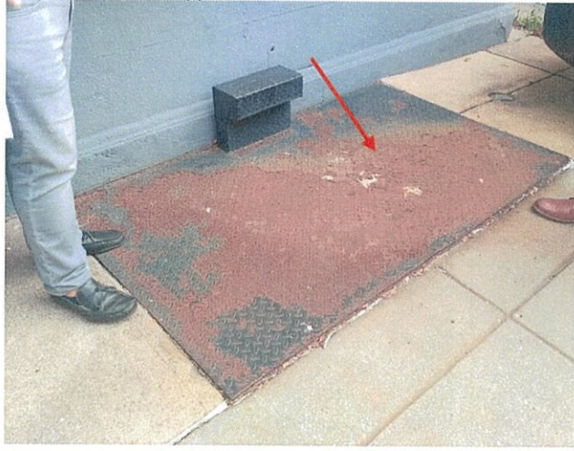
Fot. 75. Widok na zniekształconą płytę stalową przy budynku i jej korozję.
