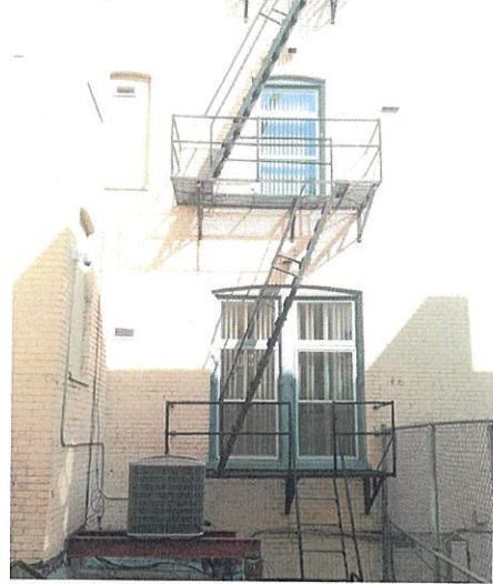
Fot. 86. Widok na klatkę ewakuacyjną budynku przeciwpożarową.
