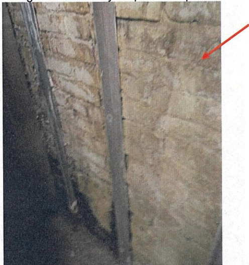
Fot. 25. Widok na zawilgocenia ścian i zagrzybienie w pom. głównego zaworu wody na poziomie piwnic.
