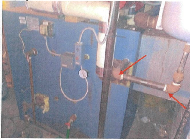
Fot. 34. Widok na instalację wraz z oprzyrządowaniem w piwnicy, korozja na elementach stalowych kształtek instalacji.
