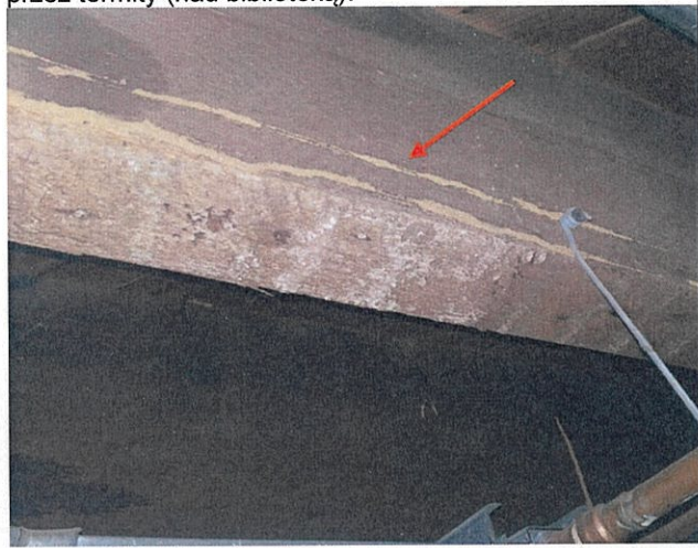
Fot. 27. Widok na belkę stropu nad piwnicą zaatakowaną przez termity (nad biblioteką).
