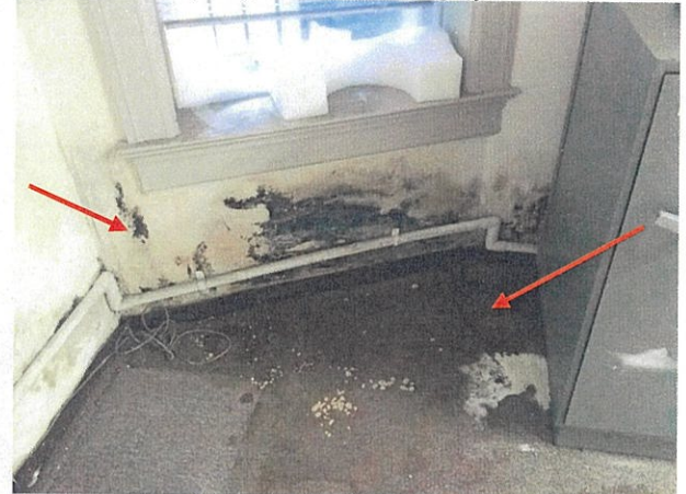
Fot. 6. Widok na zawilgocenia w pom. piwnicznym przy schodach zewnętrznych i znaczne zagrzybenie.
