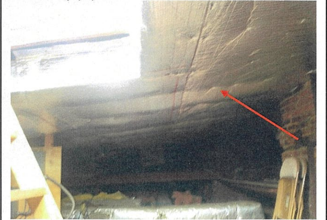
Fot. 66. Widok na przestrzeń poddasza nieużytkowego - ocieplenie przy pomocy wełny z zabezpieczeniem folią aluminiową i papierem.
