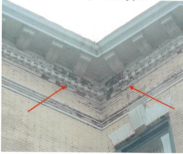
Fot. 75. Widok na zniekształconą płytę stalową przy budynku i jej korozję.
