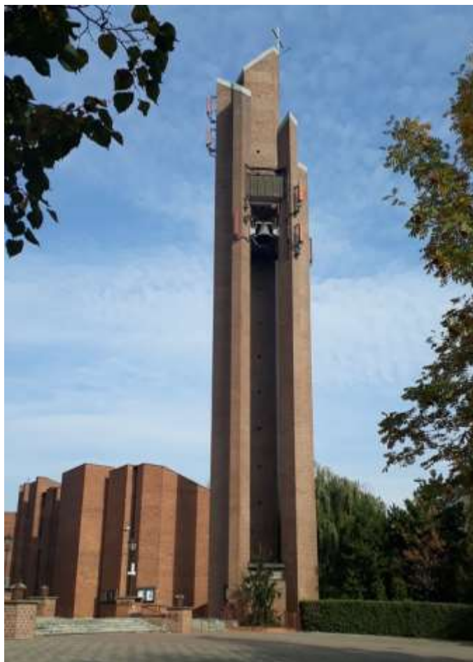
Fot. 1: Widoki anten stacji bazowych ID: WAR1082 oraz ID: 1761, zlokalizowanych: ul. Św. Bonifacego 9, 02-914 Warszawa
