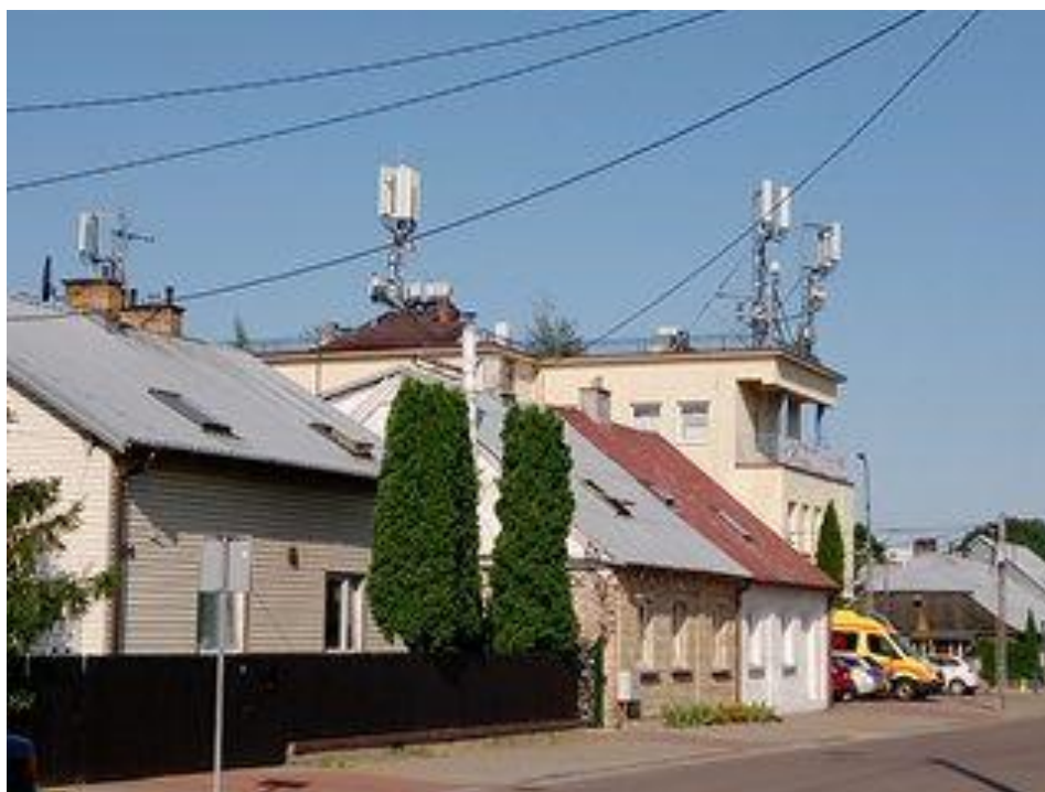
Fot. 1: Widok anten stacji bazowych ID: BIA1046A, ID: 7395 (96920N!), zlokalizowanych pod adresem: Nowowarszawska 32/2, 15-206 Białystok
