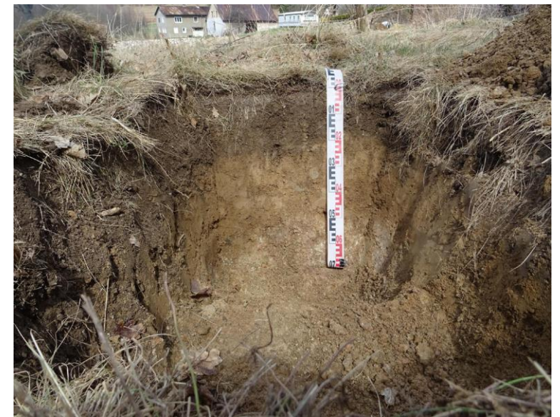
Rys. 3 Odkrywka do poziomu skalistego podłoża
