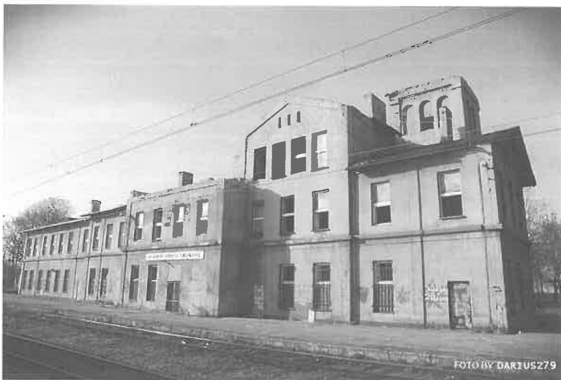
Wygląd budynku Dworca w Strzemieszycach przed wyburzeniem
