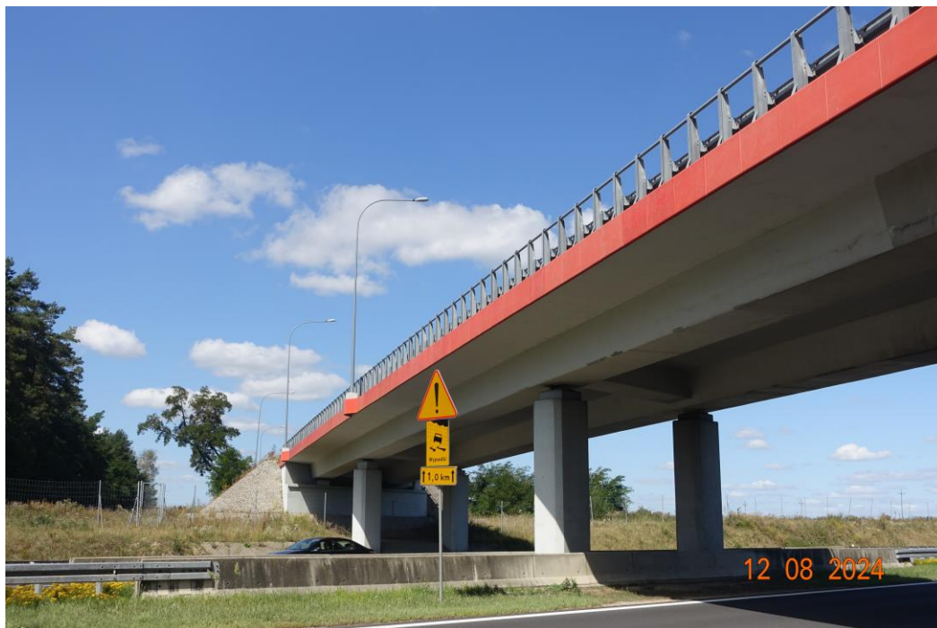
Widok na dźwigar od strony Łodzi. Przyczółek po stronie jezdni prawej
