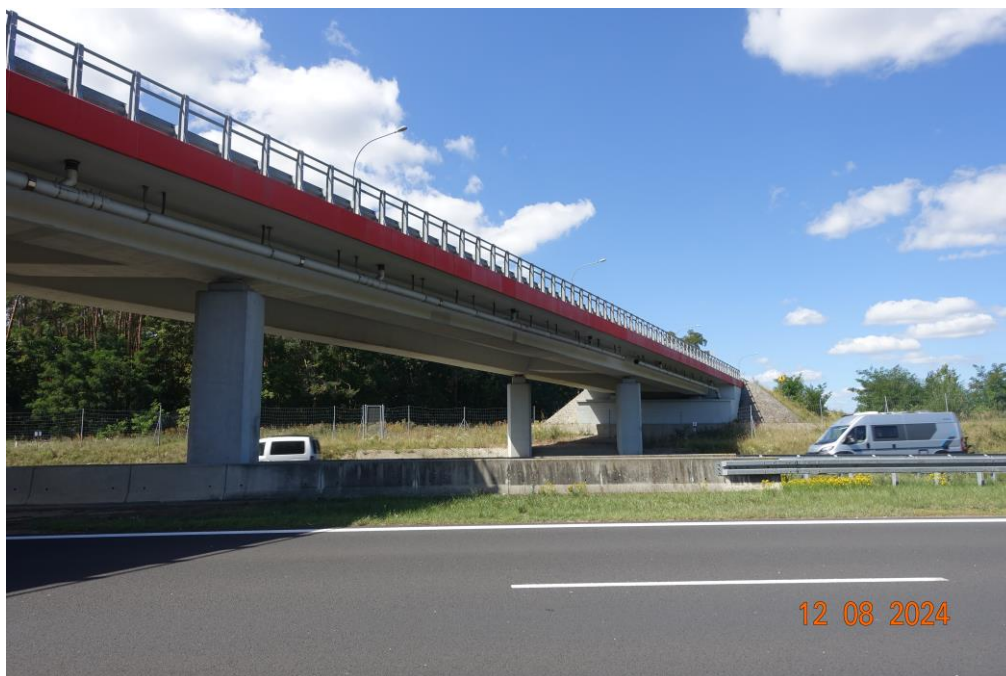
Widok obiektu od strony Gdańska
