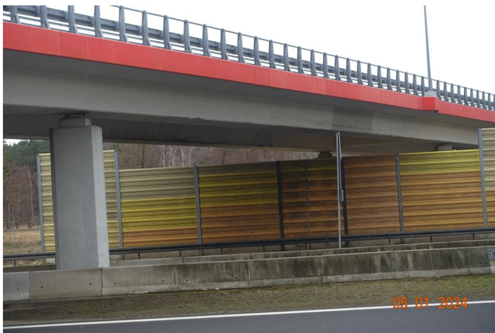
Widok dźwigara od strony Łodzi
