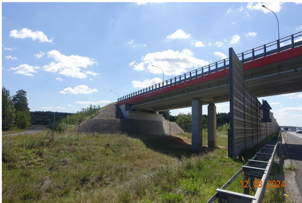
Widok na przyczółek od strony Gdańska na jezdni lewej
