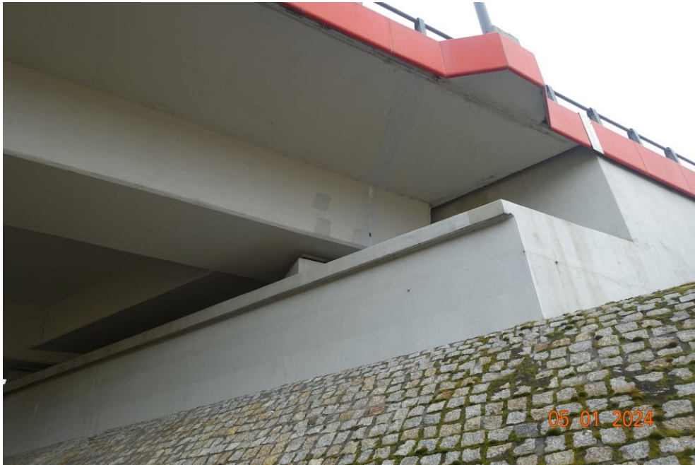
Widok na przyczółek jezdni prawej od strony Gdańska
