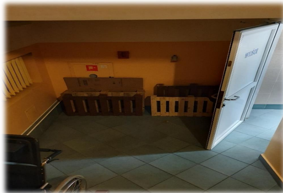
Fotografia 6 Materiały palne na drodze ewakuacyjnej.
