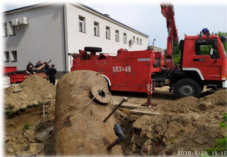
Fotografia 57 Demontaż stacji paliw.
