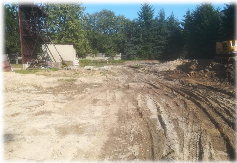
Fotografia 29 Prace ziemne związane z budową boiska wielofunkcyjnego
