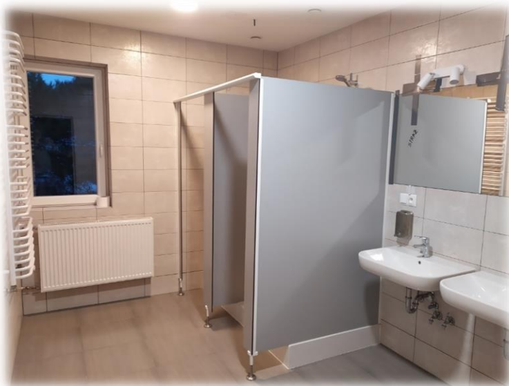
Fotografia 56 Remont pomieszczenia łazienki.
