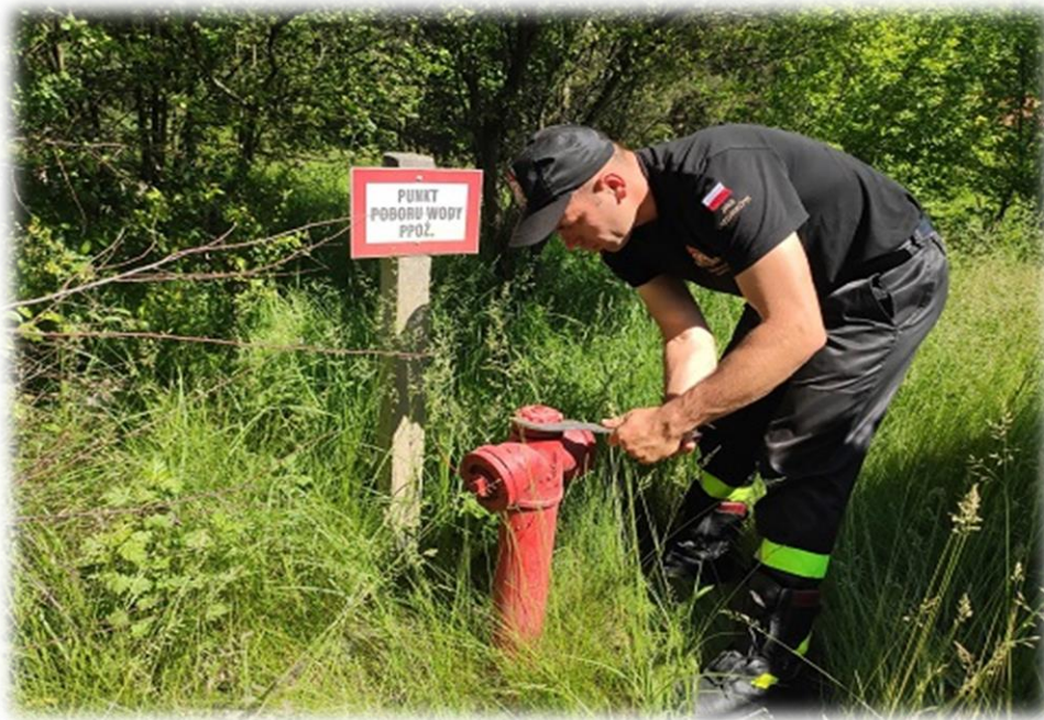
Fotografia 41 Kontrola sprawności sieci hydrantowej i hydrantów zewnętrznych (gm. Parzęczew).
