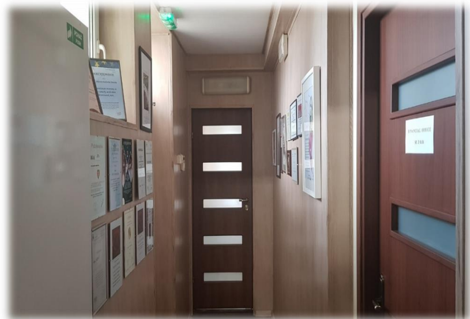
Fotografia 10 Siding na drogach ewakuacyjnych.
