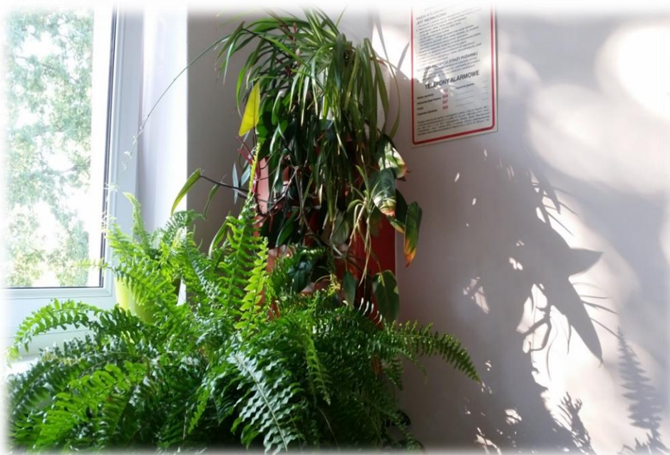
Fotografia 8 Zastawiony hydrant wewnętrzny.
