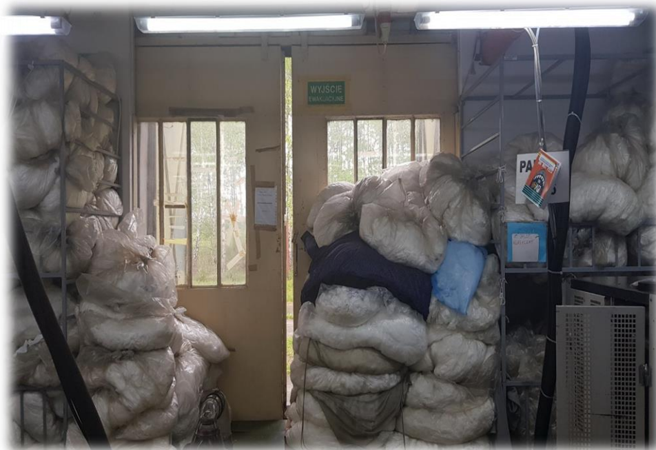
Fotografia 11 Wyjście ewakuacyjne zastawione materiałami łatwopalnymi w budynku PM.
