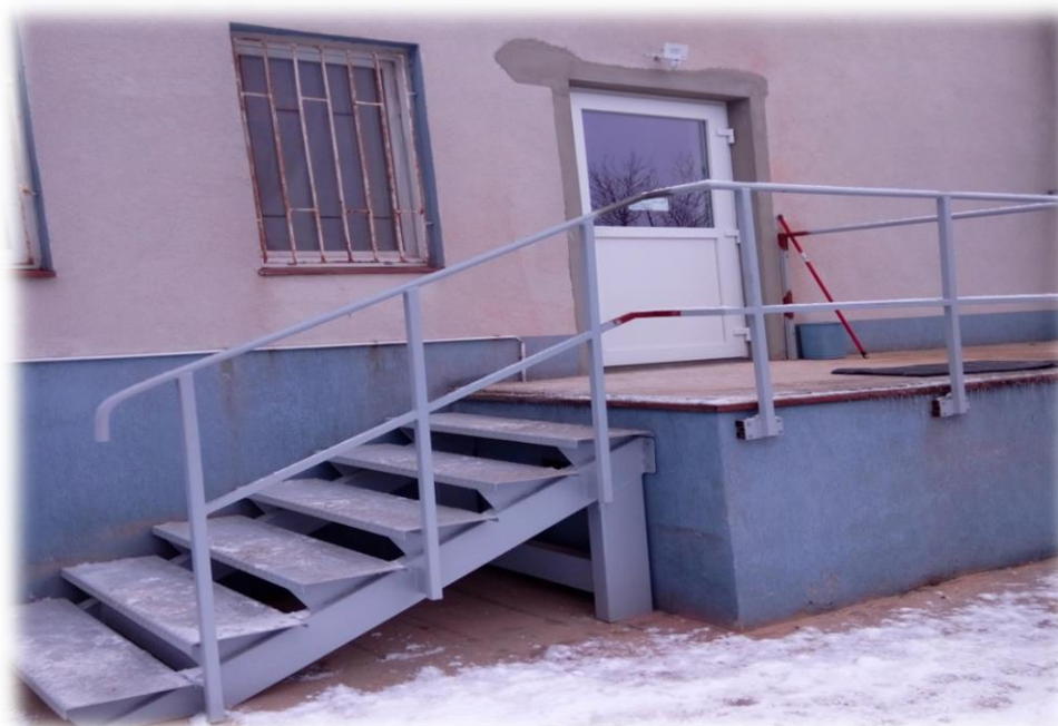
Fotografia 58 Nowe wejście do budynku JRG w Strykowie dla ZRM
