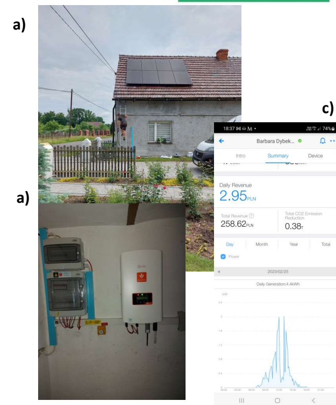
Rys. Stanowisko badawcze (instalacja pilotażowa) – fotowoltaika 2,96 kW [fotografia G. Wałowski]: a) zmontowane panele, b) instalacja, c) monitoring produkcji prądu.
