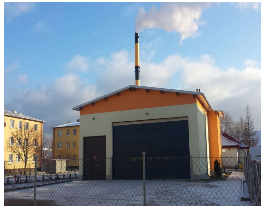
Rys. Ciepłownia osiedlowa w Ruciane-Nida – widok ciepłowni.
