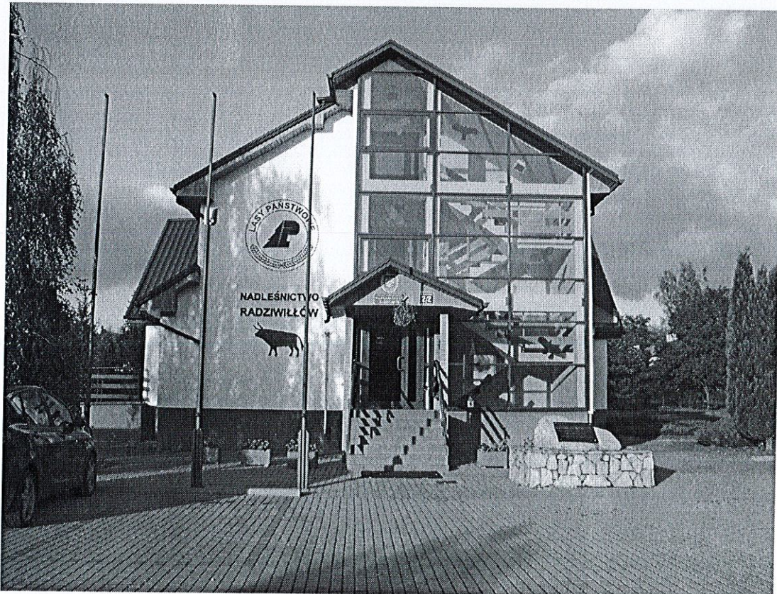
Widok analizowanego obiektu – elewacja frontowa
