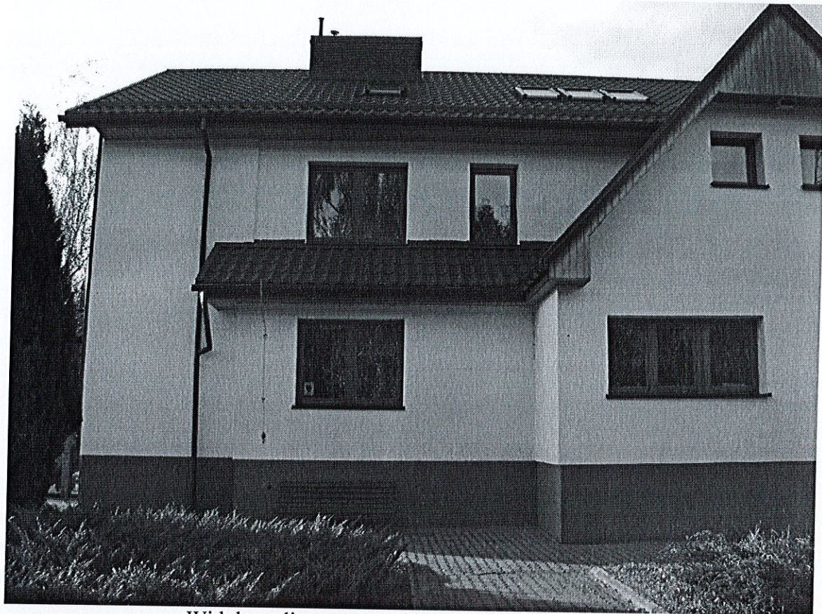
Widok analizowanego obiektu – elewacja boczna
