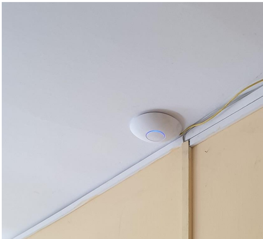
Fot. 3: Zdjęcie punktu dostępowego model UniFi UAP-PRO
