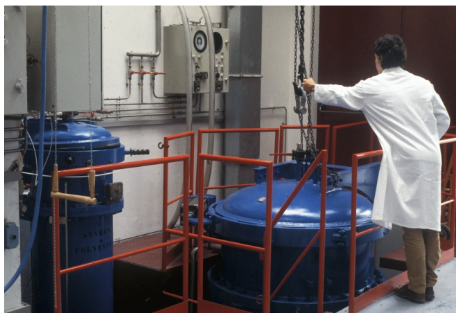
Pionowa instalacja próżniowa do osuszania wyrobów przed procesem konsolidacji radiacyjnej.
