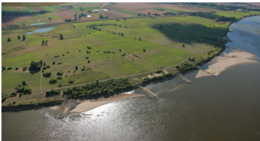
Kompleksowe Zabezpieczenie Przeciwpowodziowe Żuław (fot. PGW Wody Polskie)
