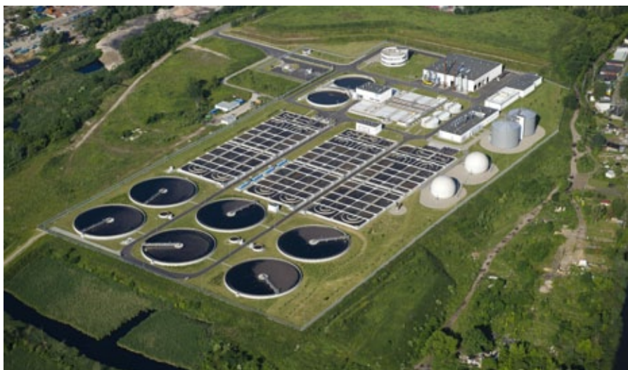
Oczyszczalnia Ścieków „Pomorzany” w Szczecinie (fot. szczeciński ZWIK Sp. z o.o.)
