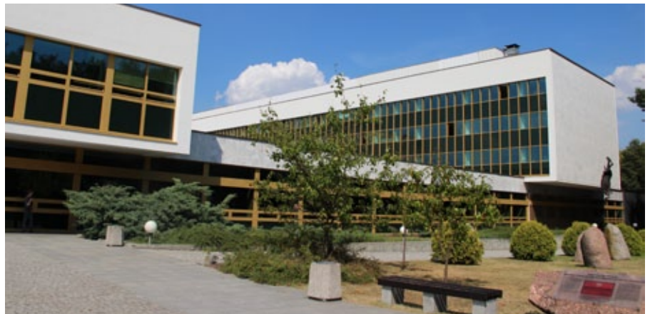
Termomodernizacja Biblioteki Narodowej w Warszawie przy Al. Niepodległości 213 (fot. Biblioteka Narodowa)
