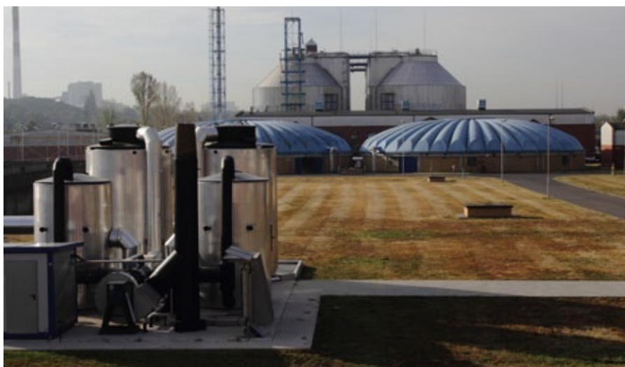
Centralna Oczyszczalnia Ścieków w Koziegłowach (fot. B. Biegowski)
