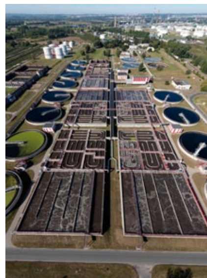
Oczyszczalnia ścieków Gdańsk-Wschód (fot. GIWK Sp. z o. o.)
