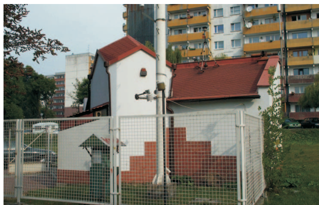
Fot.3. Stacja pomiarowa w Sosnowcu
