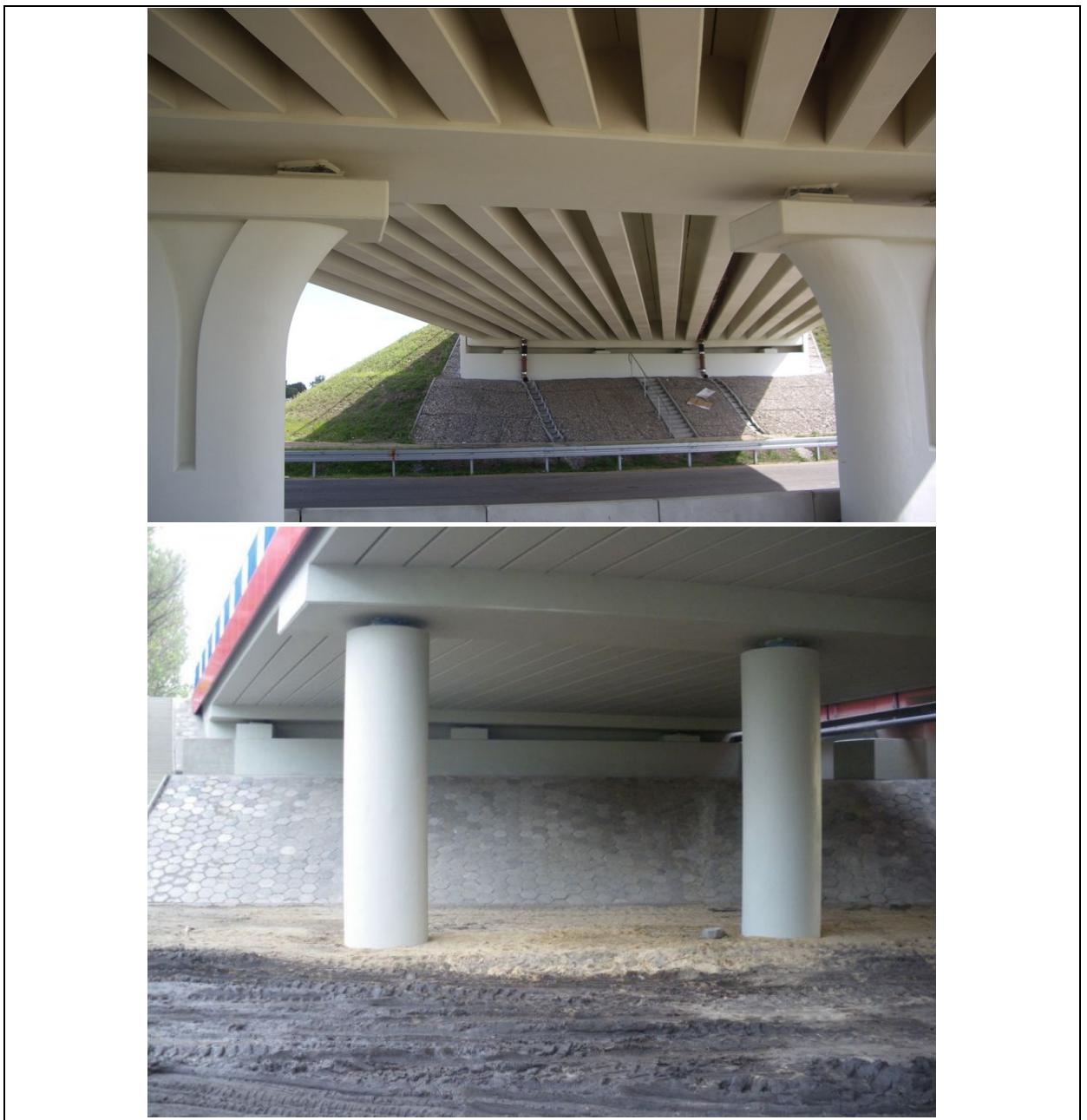
Rys.55. Wiadukt z belek typu T oraz wiadukt z belek Kujan.
