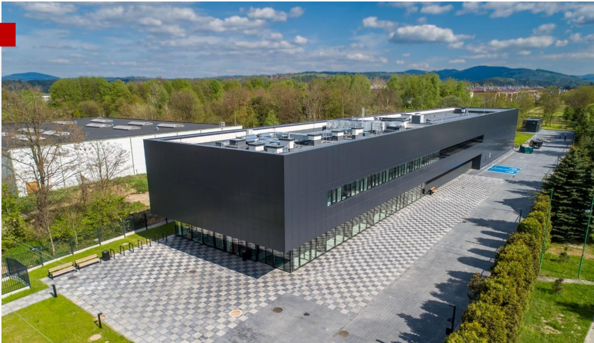
Nowy budynek Oddziału w Nowym Sączu AN w Krakowie, fot. AN w Krakowie
