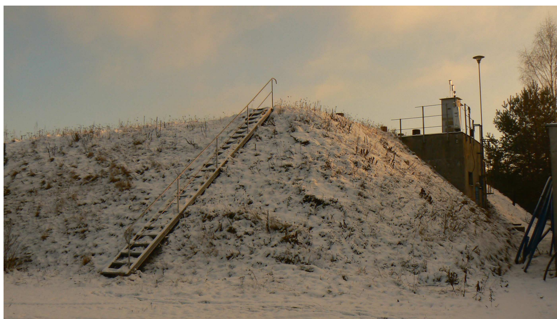
Rysunek 2.4. Lokalizacja i widok stanowiska manualnych pomiarów stężenia rtęci w Lublińcu przy ul. Piaskowej 56 (rtęć w fazie gazowej i związanej z PM 10 , PM 2,5 i PM 1 )
