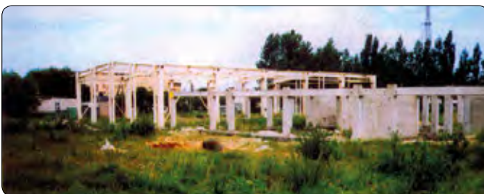
JRG 2, ul. Hutnicza (budowa) – 1992 r.
