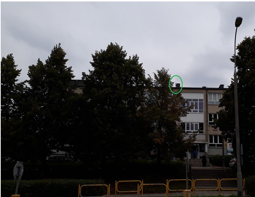
Rys. 4 Miejsce montażu pilotażowego SMS PEM – SP nr 2 w Olsztynie – widok z poziomu gruntu
