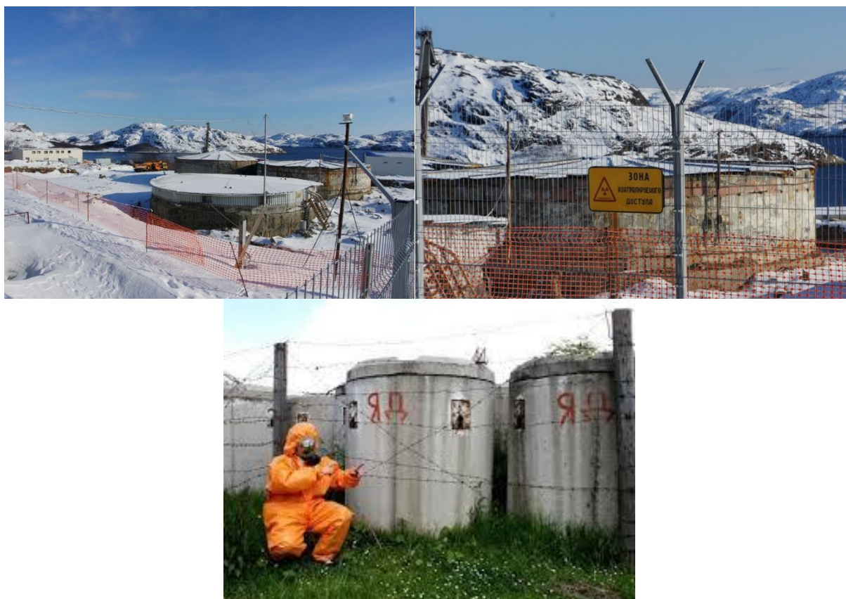
Rys. 2, 3, 4 Warunki przechowywania wypalonego paliwa na składowisku w Zatoce Andriejewa
