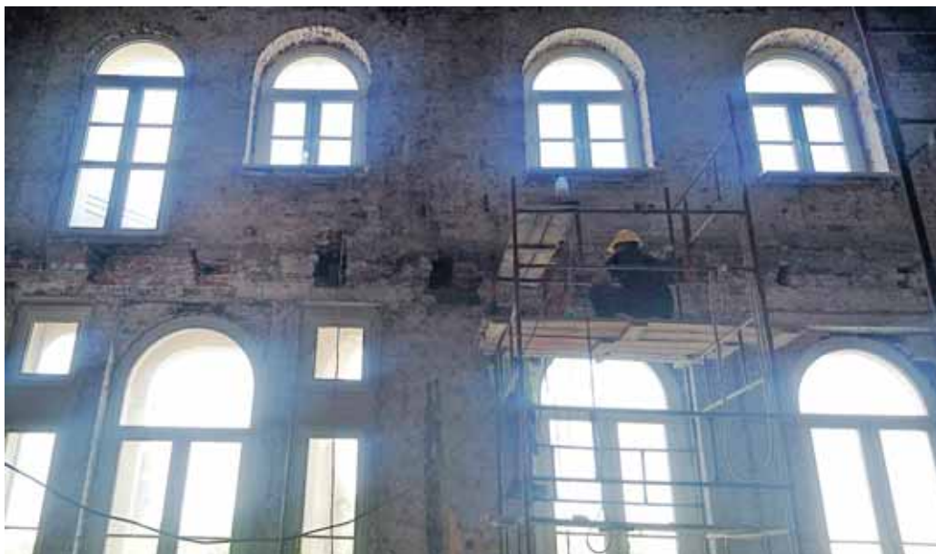
Okna drugiego i trzeciego piętra budynku nr 68 podczas wymiany stropów
