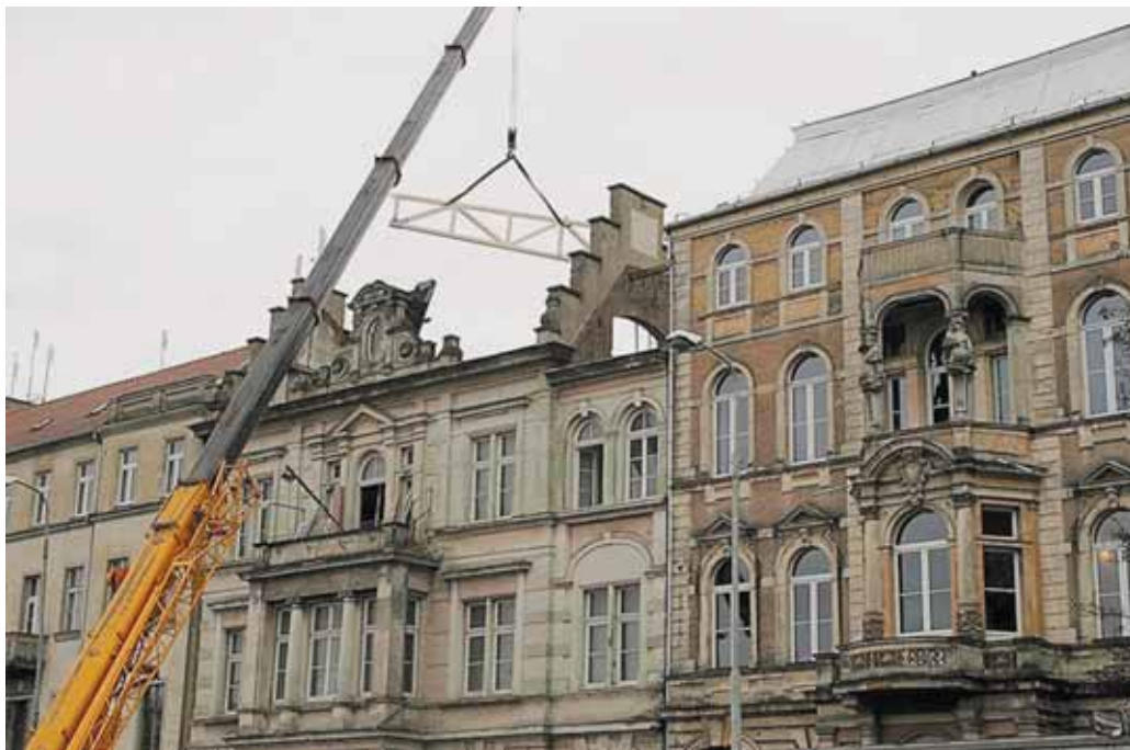
Wymiana łamanego dachu budynku nr 69 w 2014 roku. W niebo wbija się kamienny szczyt i schodkowy mur ogniowy
