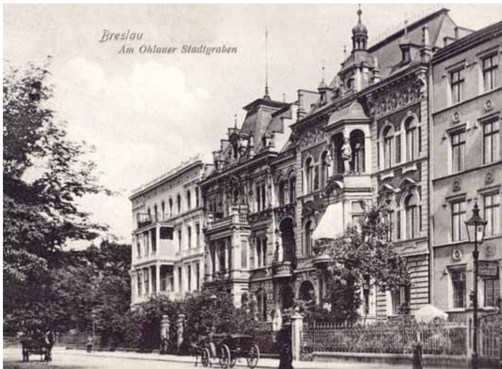
Na Podwalu Olawskim — pocztówka (z 1910 roku) z archiwum szkoły ukazująca kamienice przed dwudziestowiecznymi przebudowami. Na pierwszym planie niezachowane: fryz na wysokości obecnego trzeciego piętra, zadaszenie ryzalitu i wieżyczka z latarnią
