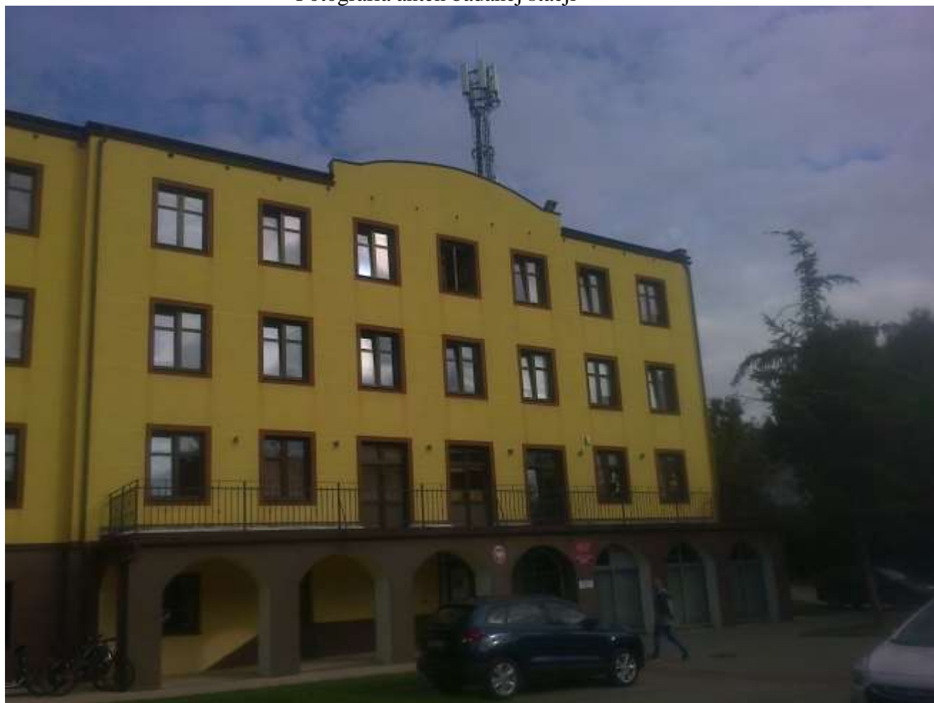
Fot. 1: Widoki anten stacji bazowej ID: GDA0046, zlokalizowanej: ul. Zakopiańska 37, 80-142 Gdańsk
