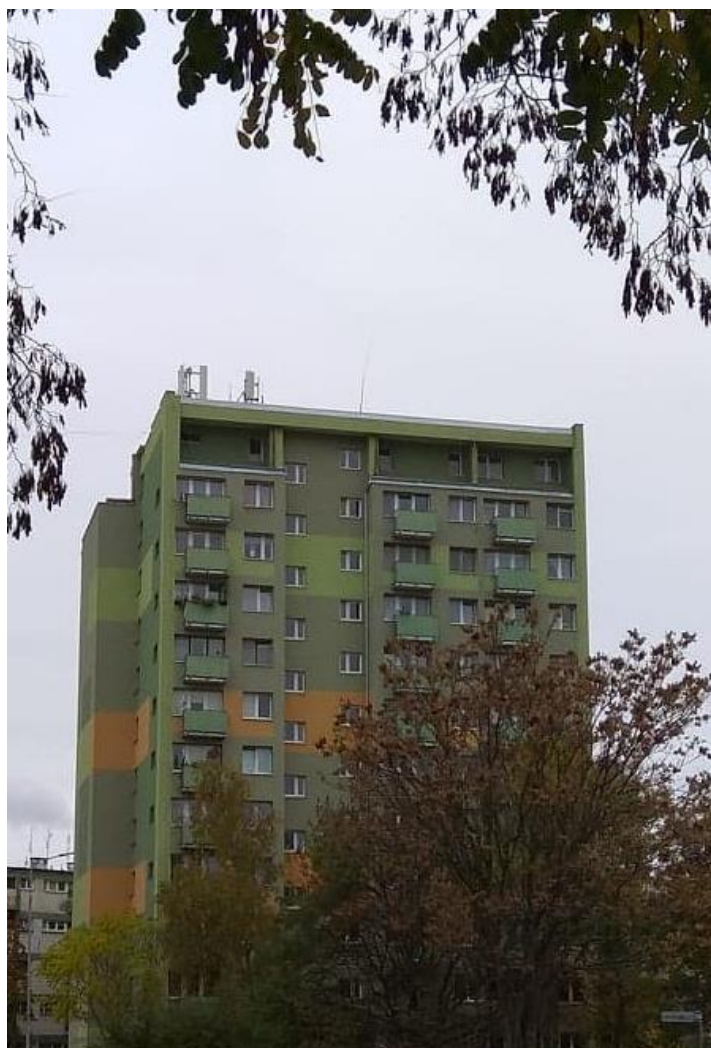
Fot. 1: Widoki anten stacji bazowej: ID: WRO1174, zlokalizowanej: ul. Żelazna 76, Wrocław
