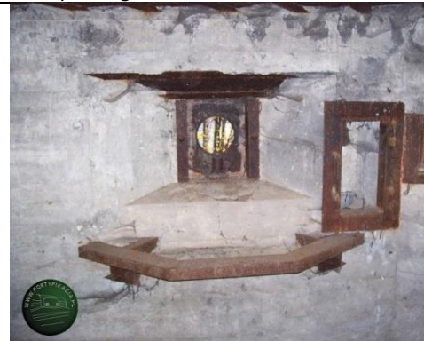
Tarcza (płyta) pancerna, po lewej ze strzelnicą z przegubem kulowym, dla armaty fortecznej wz.38 w polskim schronie bojowym Grupy Bojowej "Krzyżowa". Poniżej – tarcza (płyta) pancerna ze strzelnicą minimalną dla ciężkiego karabinu maszynowego.
