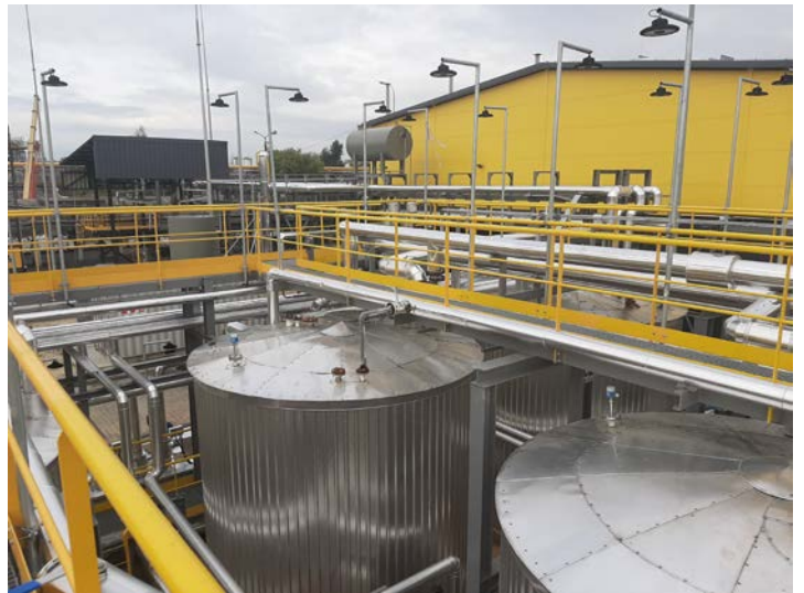
Kolejny etap tworzenia pilotażowej instalacji, Kędzierzyn Koźle, fot. Lucyna Korzekwa/Dariusz Żłobiński
