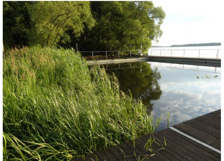
Wysokoefektywna strefa ekotonowa (roślinna strefa buforowa wraz z barierą na bazie wapienia) na poligonie demonstracyjnym, Zarzęcin, fot. EKOROB
