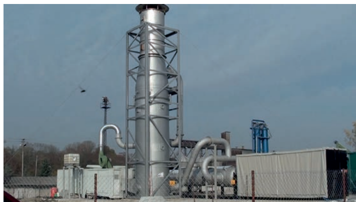
Mobilna linia demonstracyjna do produkcji energii elektrycznej z odnawialnych źródeł – zmikronizowanej biomasy, fot. Marta Karnowska
