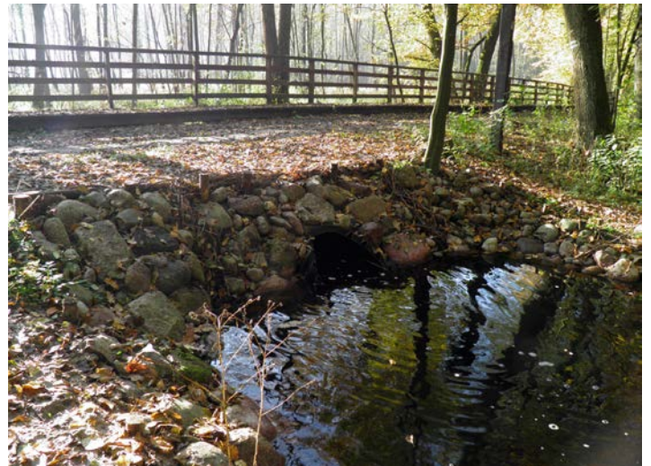
Przepust na Wilczej Strudze w Kącie Góry – 16.10.2017, fot. Anna Andrzejewska
