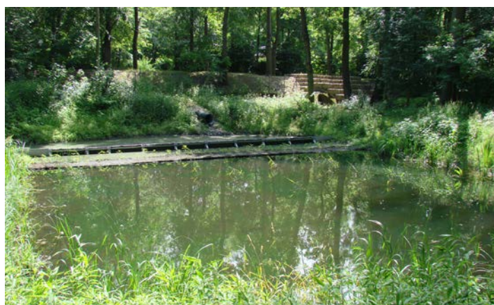
System hybrydowy skonstruowany poniżej ulicy Wycieczkowej do retencjonowania i podczyszczania wód opadowych, fot. Tomasz Jurczak
