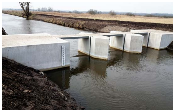
Jaz Nr 1 – w trakcie budowy, fot. T. Bocian
