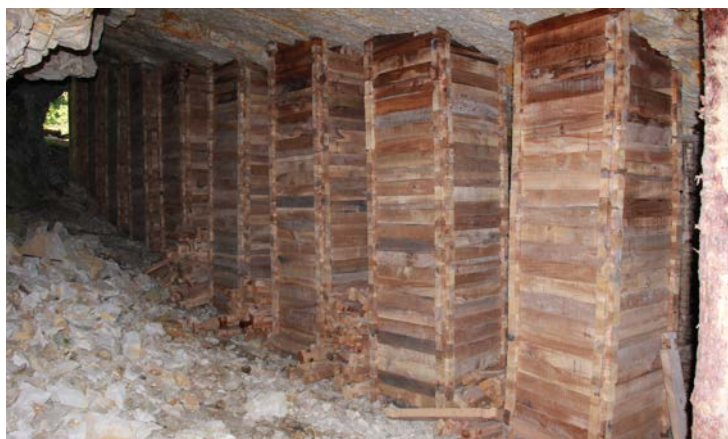
Prace w jaskini – tymczasowa obudowa podporowa fot. Przemysław Skrzypiec
