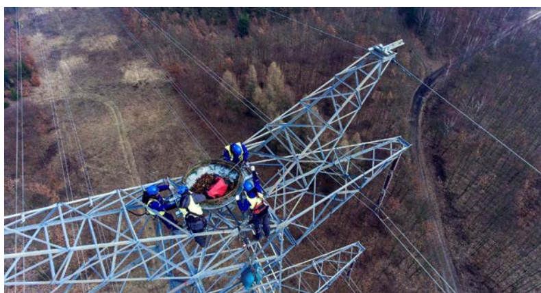
Montaż platformy na słupie energetycznym PSE S.A, fot. Marek Matecki
