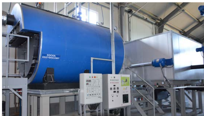
Zespół spalania osadu pościekowego, fot. Fu-Wi Sp. z o.o.
