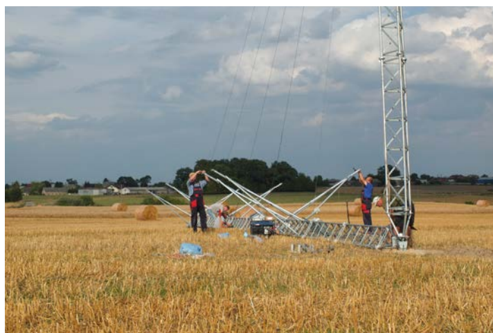
Montaż masztu pomiarowego, fot. archiwum projektu OZERISE koordynowanego przez Instytut Energetyki Odnawialnej
