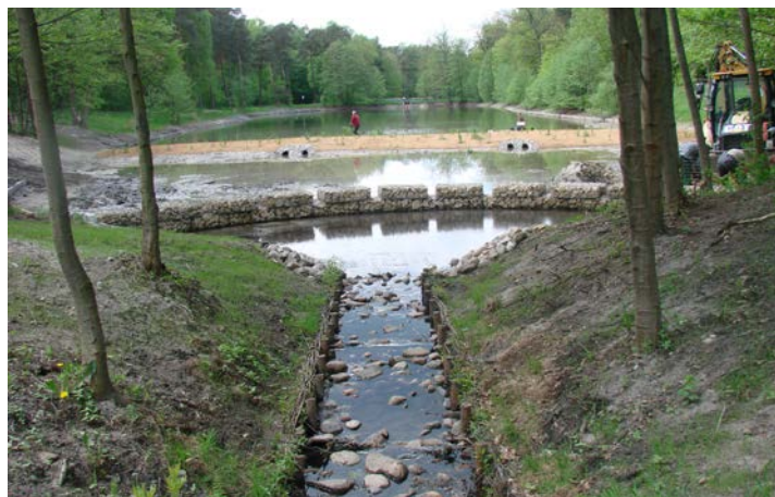
Sekwencyjny system sedymentacyjno-biofiltracyjny skonstruowany w zbiorniku Arturówek Górny, fot. Tomasz Jurczak
