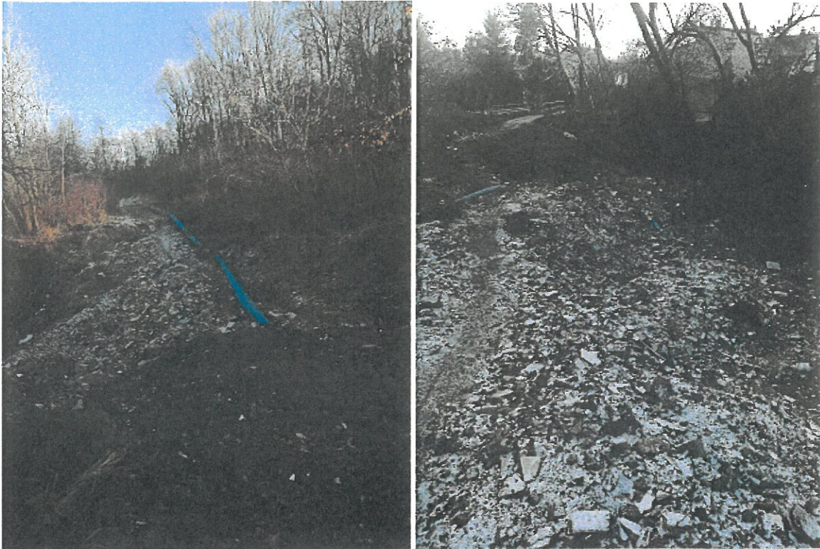
Rys. 20 Stan drogi w Lednicy Górnej w rejonie ul. Solarskiego i rzeki Świdówki
