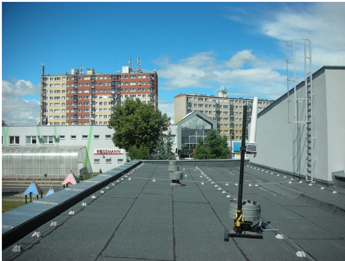
Rys. 3 Miejsce montażu SMS PEM – Szkoła Podstawowa nr 6 w Pile – widok na SBTK
