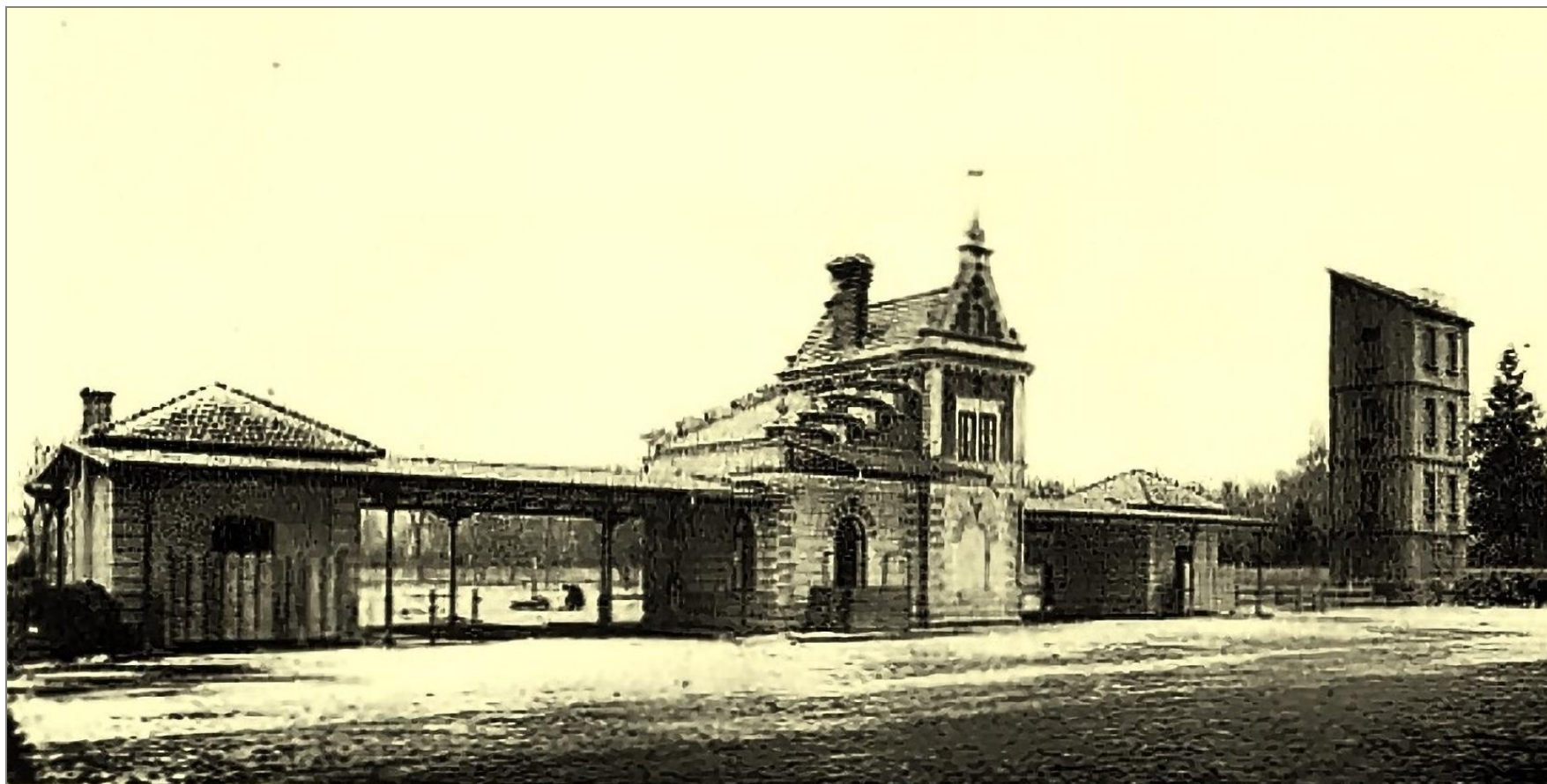
Strażacka wspinalnica wybudowana na tzw. targowicy w Rzeszowie w 1896 r.
