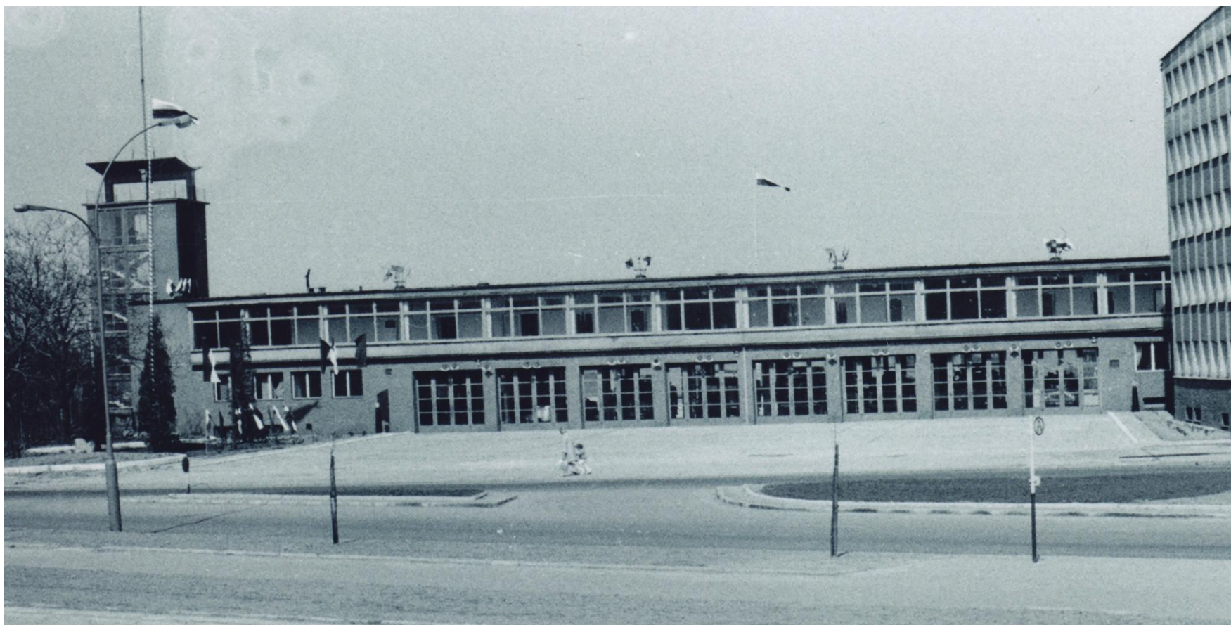
Nowa siedziba straży pożarnej przy ul. Mochnackiego 4 w Rzeszowie (1967 r.).
