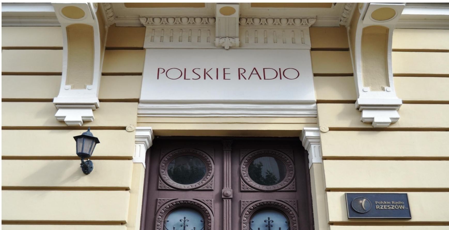
Siedziba Polskiego Radia w Rzeszowie. Wejście główne do budynku. Stan obecny (2022 r.).
