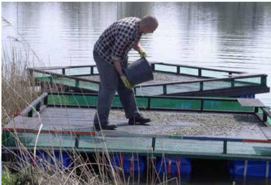
Sztuczne wyspy podczas wodowania i pokrywania żwirem.
