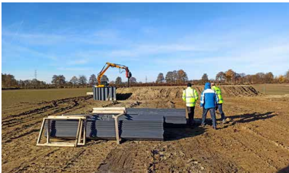
Wyspa w trakcie umacniania brzegów grodzicami PCW.
