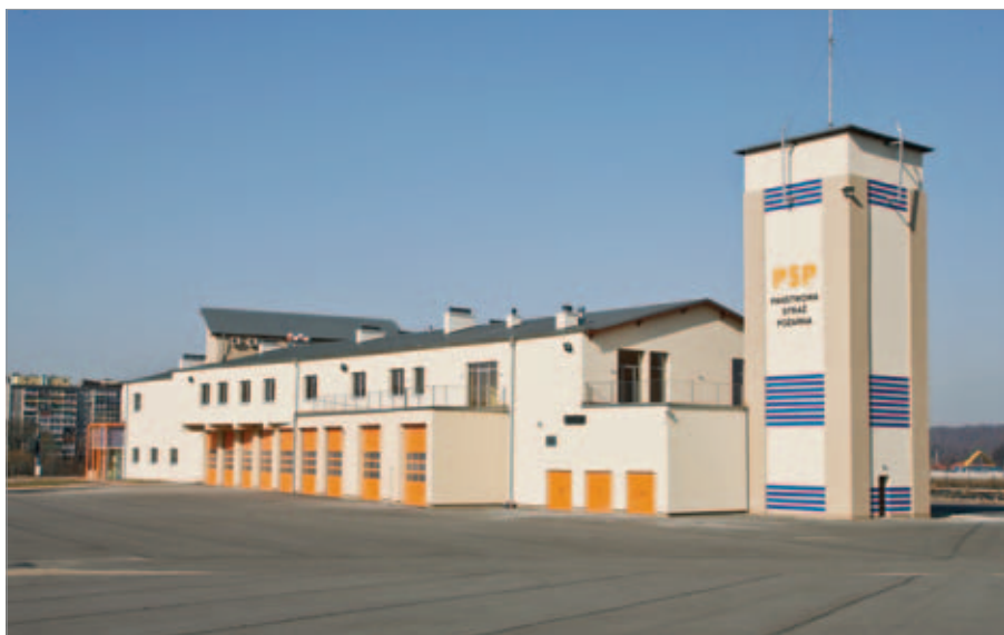
Budynek KM PSP w Wałbrzychu
