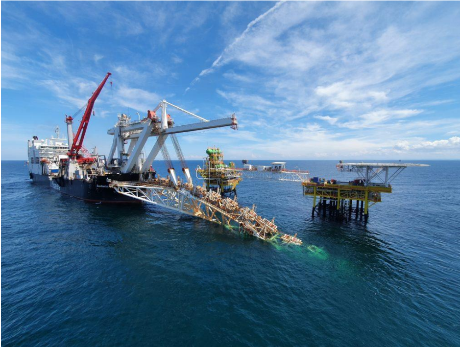
Rysunek 14. Montaż rurociągu ze statku o specjalnym oprzyrządowaniu (Allseas).
