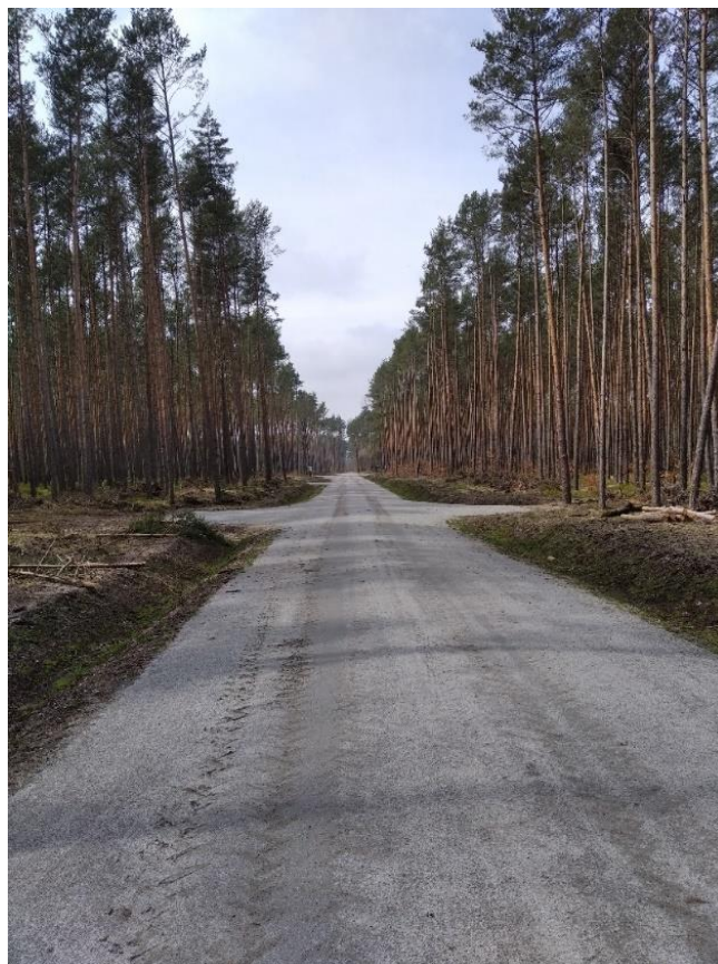
Zdjęcie 12. ZMODERNIZOWANY DOJAZD POŻAROWY NR 6 – OBRĘB OŁAWA (FOT. M. DROZD)
