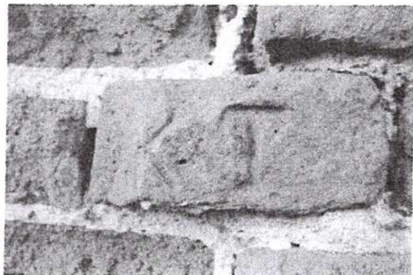
Fot. 10. Gwóźdź umieszczony w cegle.
