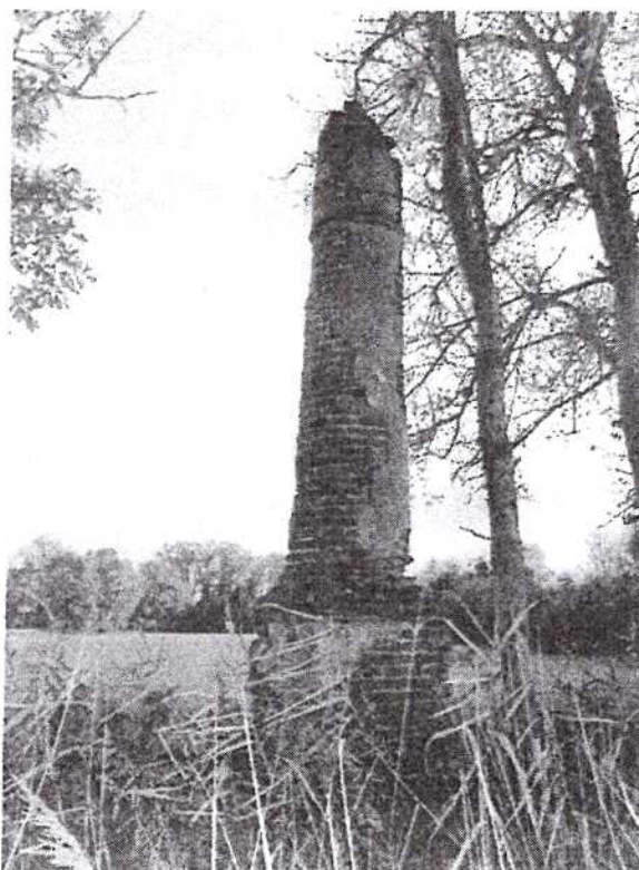
Fot. 2. Fot. Obecny stan kolumny, widok od strony północnej.
