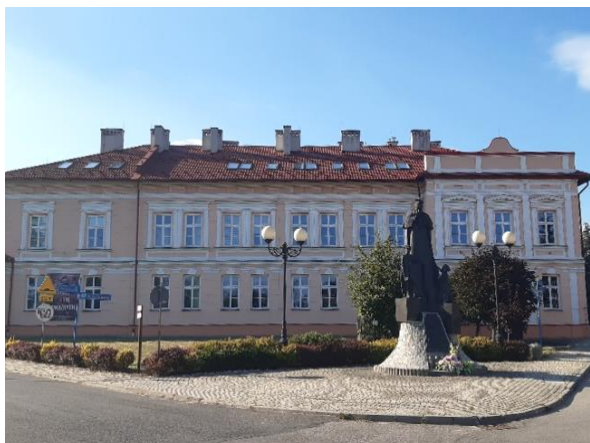
Rys.3.6. Budynek Samorządowego Liceum Ogólnokształcącego w Głogowie Małopolskim
