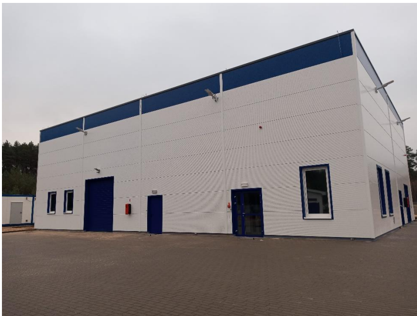
4. Budynek magazynowy na terenie Kopalni Ropy Naftowej i Gazu Ziarnego Lubiaków w Grotowie.
