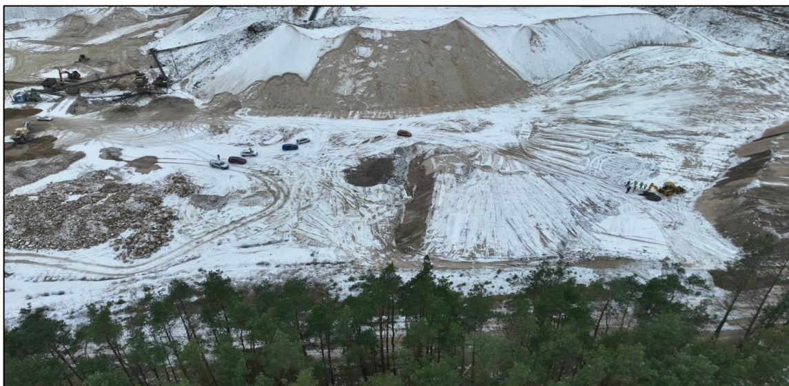
Zdjęcie 28. Zakopywanie rozdrobnionych odpadów komunalnych w wyrobisku.
