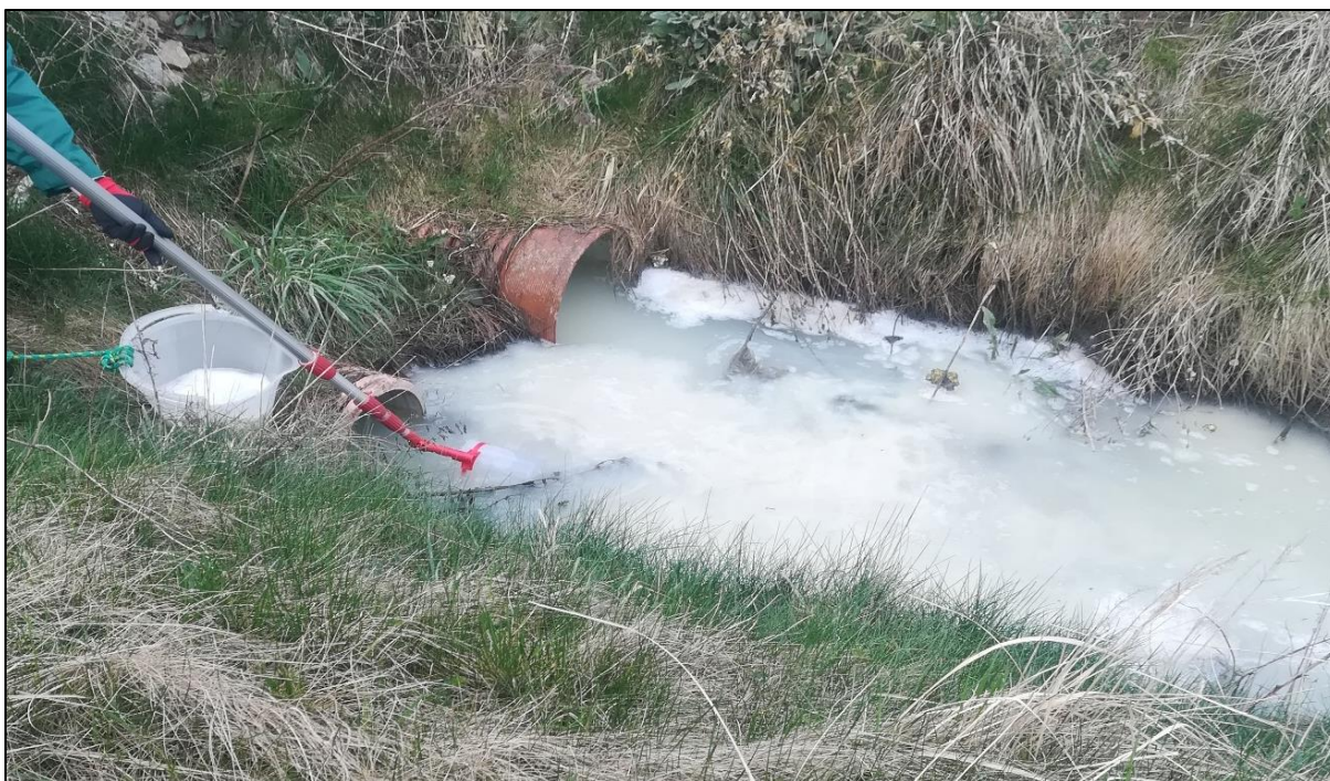
Zdjęcie 27. Wylot kanalizacji.
