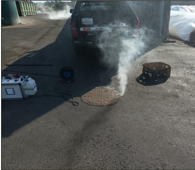
Zdjęcie 2. Wykorzystanie „zadymiarki” podczas kontroli zakładu w Świdnicy
