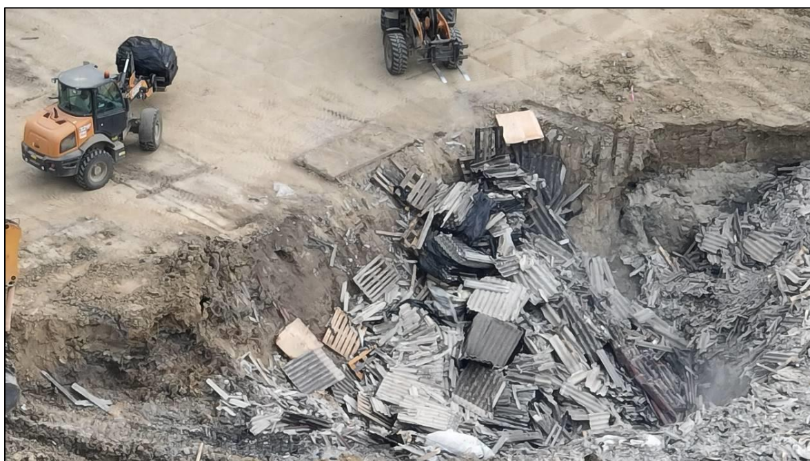
Zdjęcie 19. Składowanie odpadów niebezpiecznych niezgodnie z przepisami ochrony środowiska oraz wbrew warunkom pozwolenia i instrukcji prowadzenia składowiska ( zrzut odpadów do prowizorycznej kwatery ).
