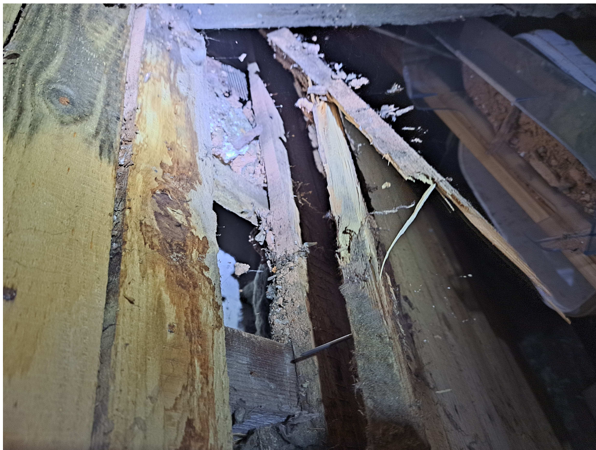
Rys. 1. Uszkodzenia dachu wokół komina budynku mieszkalnego – od strony wewnętrznej (z pomieszczenia strychu).
