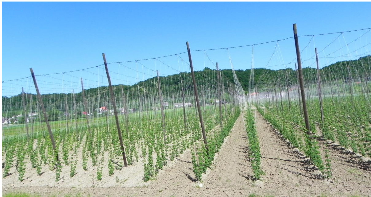
Fot. 1. Konstrukcja wsporcza chmielnika wykonana ze słupów drewnianych impregnowanych olejem kreozotowym w rozstawie 9 \times 9 m.
