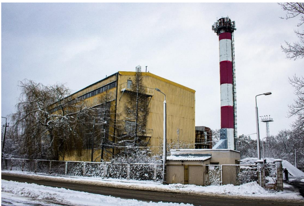
Rys. 3 Centralna Ciepłownia w Dęblinie
