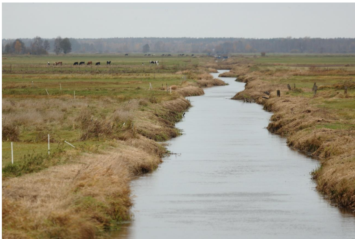
Fot. 1. Rozoga - uregulowane koryto rzeki w okolicach miejscowości Lelis (fot. T. Baldyga).
